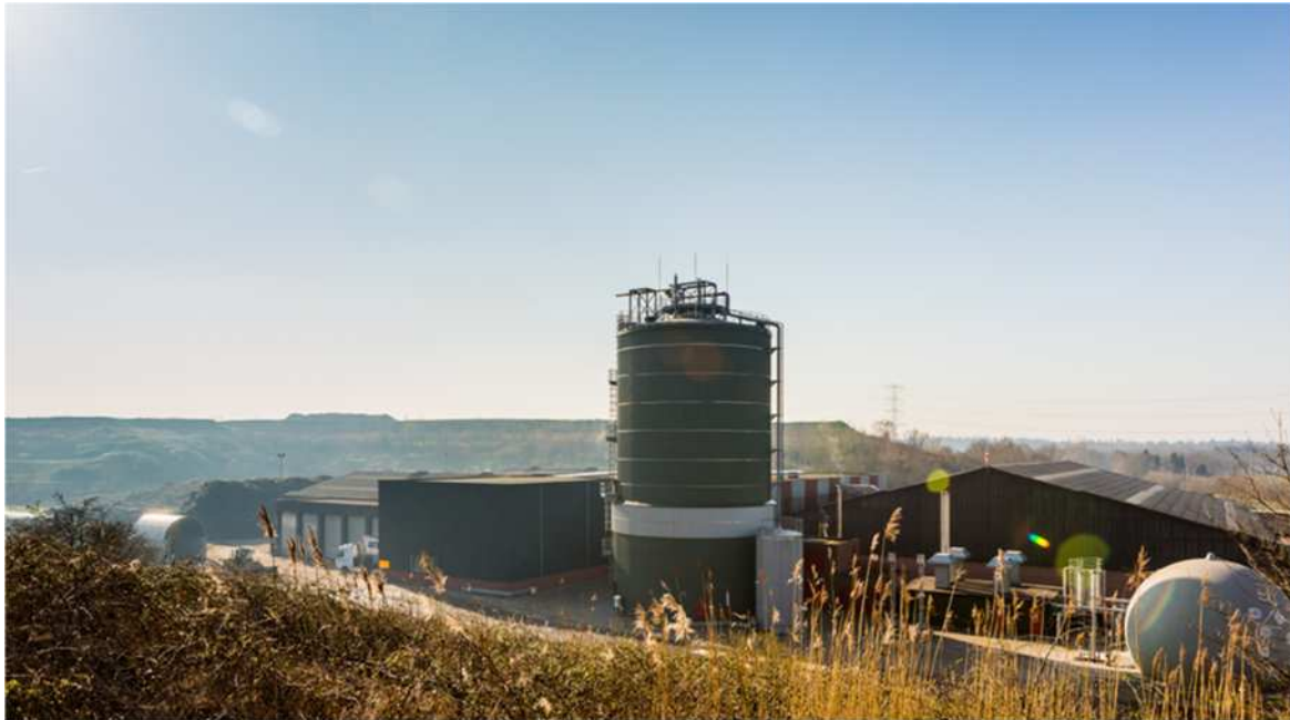
Abb. 23: Vergärungsanlage Hengelo; Quelle: OWS
