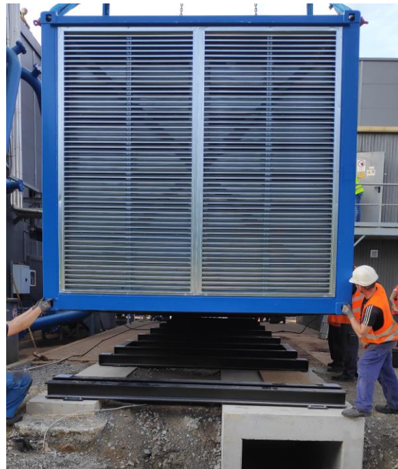
Abb. 6: Foto vom BHKW-Standort beim Aufstellen von einem der beiden BHKW-Container
