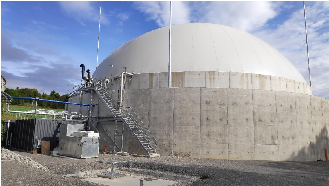
Abb. 2: Foto des Flüssigdüngerspeichers mit umgebendem Havariebecken
