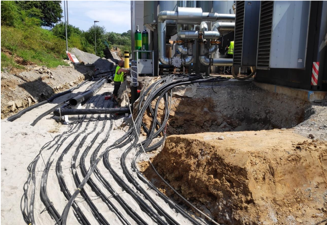
Abb. 5: Foto vom BHKW-Standort mit noch offener Baugrube für die Rohrleitungs- und Kabelverlegung sowie die Verlängerung des Fundamentes
