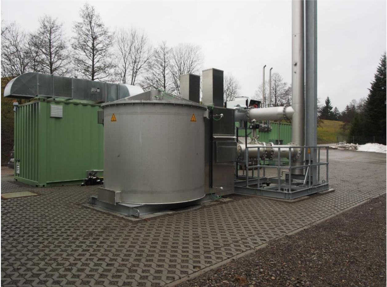
Abbildung 7: Deponie Bengelbrunn - Gasförderstation für Gut-/Schwachgas, RTO mit Wärmegleichrichter und Wärmetauscher
