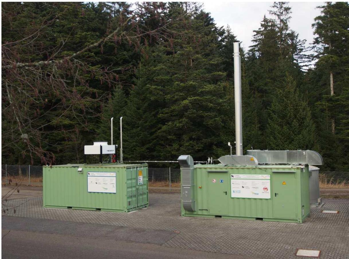
Abbildung 13: Deponie Bengelbruck - neue Entgasungsanlage
