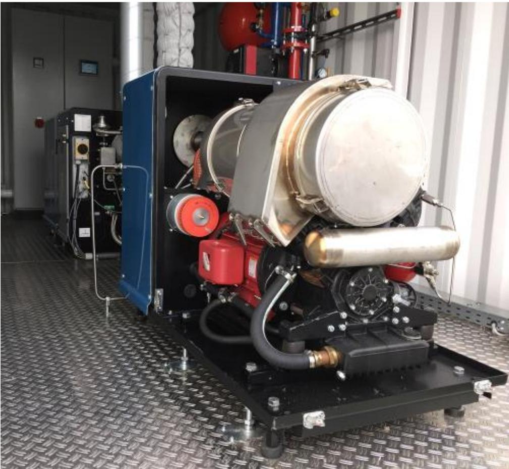
Abbildung 10: Stirlingmotoren der Deponie Bengelbruck
