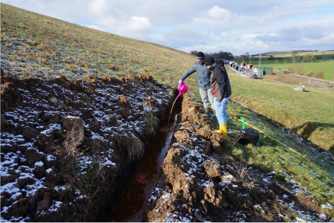
Abbildung 8: Eingabe von 50 g Eosin in den Baggerschurf oberhalb des Lysimeterfeldes. Der Graben wurde zuvor mit 270 L Wasser vorbefeuchtet.
