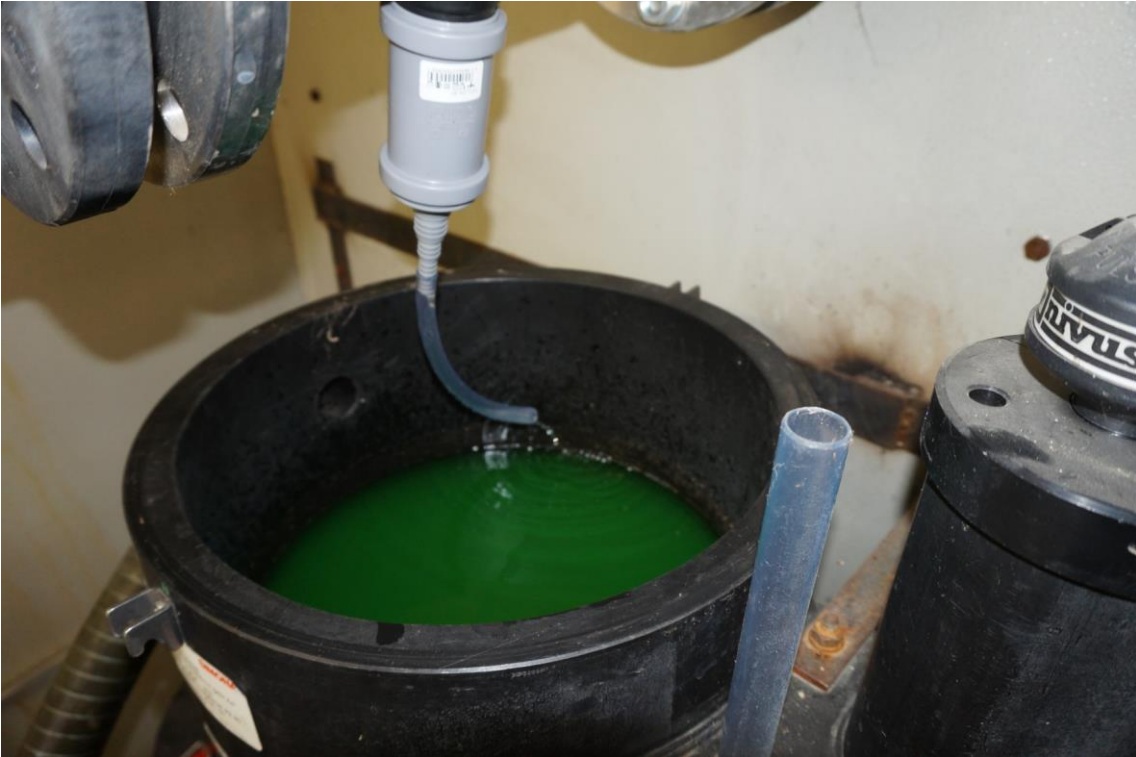
Abbildung 17: Deutlich grüne Verfärbung des Oberflächenabflusses bereits kurze Zeit nach der Eingabe. Zeit der Aufnahme ca. 15 Uhr am Tag der Eingabe.
