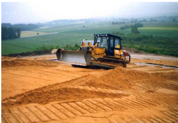
Abbildungen 3 a, b: Einbau der Kapillarschicht
