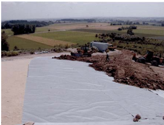
Abbildung 4: Einbau der Schluffschicht
