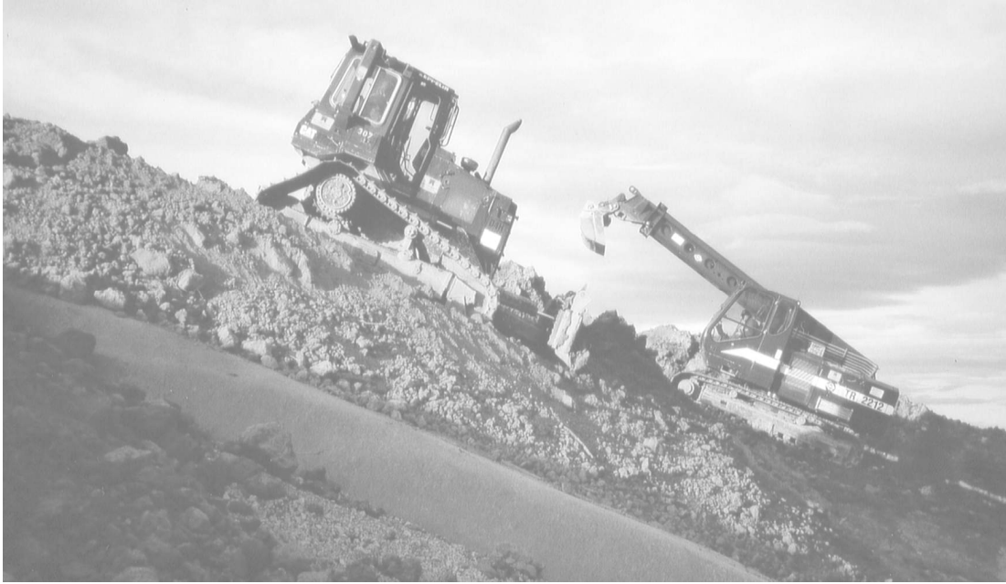
Abb. 4: Einbau der Rekultivierungsschicht im Testfeld „lockere Schüttung“
