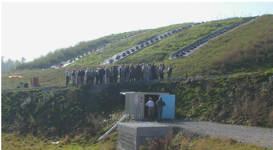
Abb. 5: Versuchsanlage auf der Deponie Leonberg im Oktober 2001, im Hintergrund links Testfeld 3 mit gut entwickelten Buschlagen
