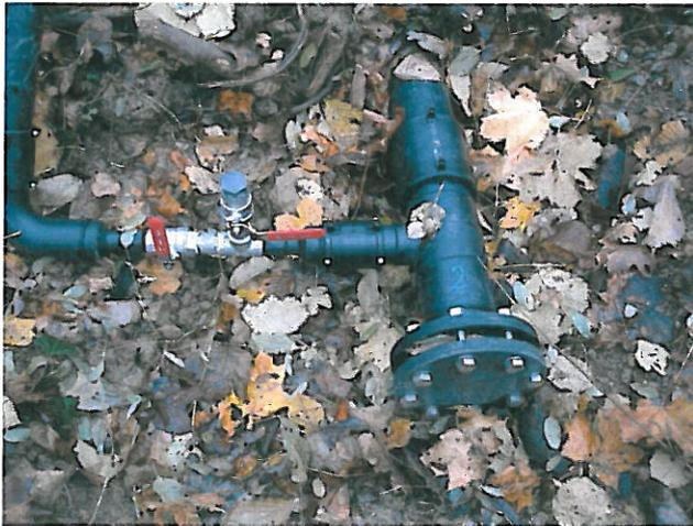
seitlichem Abgang mit der Nennweite Da 63 versehen. Die Gaslanzen wurden anschließend mit einem Kompressor auf Funktion getestet. Hierzu wurden für 10 Minuten 300 l/min in die Gaslanze eingepresst. Es wurde festgestellt, dass alle fertig gestellten Gasdrainagen den Gasfluss einwandfrei gewährleisten.
