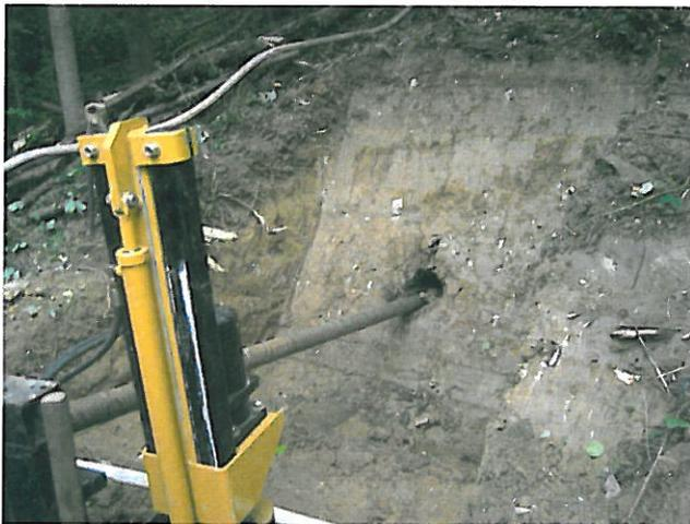
des Gefälles auf, mithilfe dieses Senders können die Lage und die Tiefe des Bohrkanals auf ca. 10 cm genau bestimmt werden.
