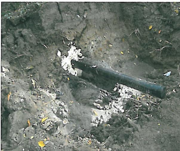
Zur Abdichtung des Bohrkanals wurden die ersten 6m der Gaslanze geschlossen ausgeführt. Die ersten 5 m des Bohrlochs wurden nach der Einbringung der Gaslanze mit einem Dichtschlamm abgedichtet. Dieser wurde nachträglich mit einer Spezialpumpe eingepresst. Dadurch kann ausgeschlossen werden, dass Luft in den Bohrkanal eindringen kann.
