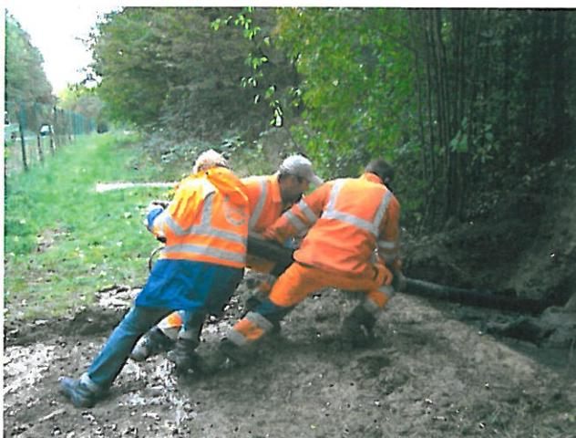
Die Filterlanze (PE80 SDR 17,4 Da 110 gelocht) zur Fassung des Deponiegases wird in das Bohrloch nachträglich eingeschoben. In der Regel konnte dies von Hand vorgenommen werden. Teilweise wurde die Lanze mit der hydraulischen Presse des Bohrgeräts eingeschoben.
