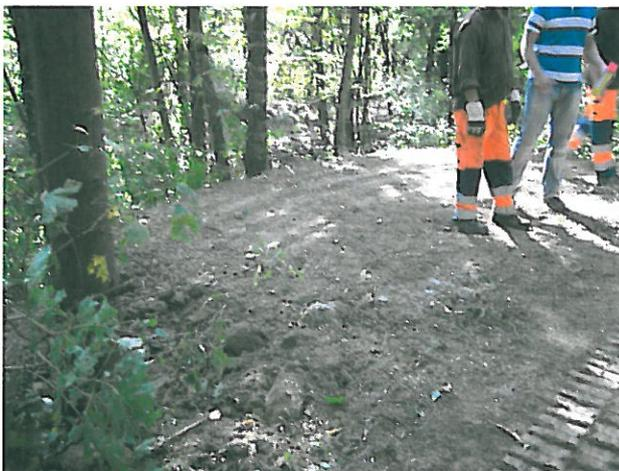
Vor Beginn der Bohrarbeiten muss eine entsprechende Ebene direkt am Bohrloch vorbereitet werden. Das Bohrgerät benötigt für den Bohrbetrieb und dem Vortrieb der Gaslanzen eine Aufstellfläche mit den Abmaßen von ca. 4,0 m Breite und 10 bis 12 m Tiefe.
