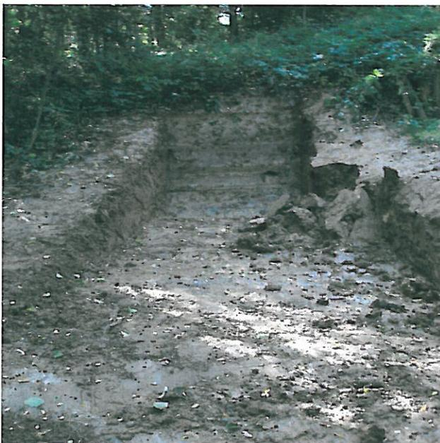
Das Bohrloch wurde mit einer kleinen Startgrube versehen, dies ist jedoch nicht unbedingt notwendig. Auf der Deponie Am Lemberg wurden kleine Startgruben angelegt, diese haben den Zweck die Endköpfe der Gasdrainagen vor mechanischen Beschädigungen zu schützen.
