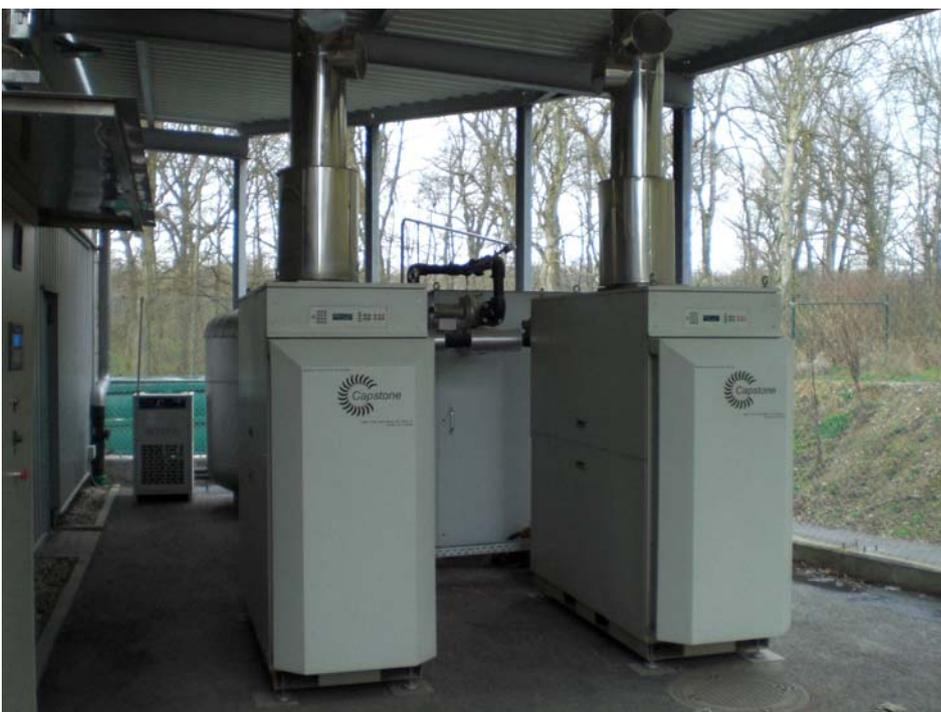
**Abb.7:** Mikrogasturbinenanlage, Detail Capstone Turbinen
