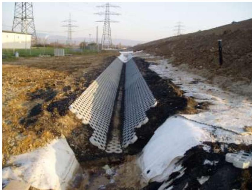
**Bild 4: Oberflächenwasserrgraben Nordrand in der Bauphase**
