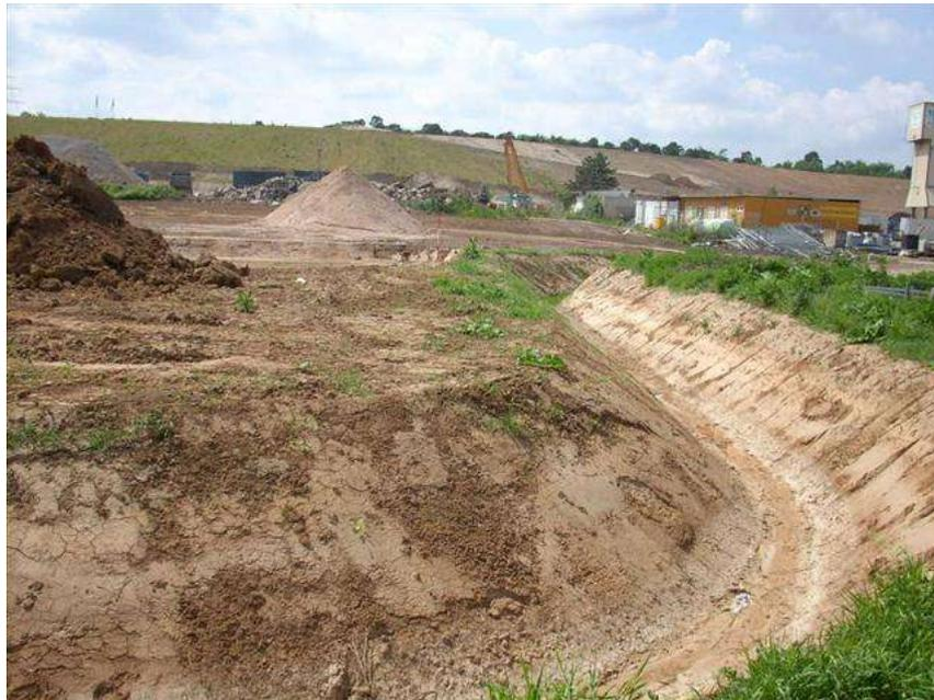
**Bild 5: Entwässerungsgraben unbefestigt außerhalb der Deponie
