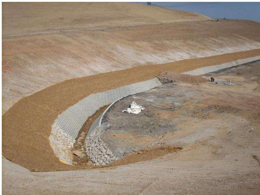
**Bild 6: Entwässerungsgraben mit Erosionsschutzmatte am Böschungsfuß
