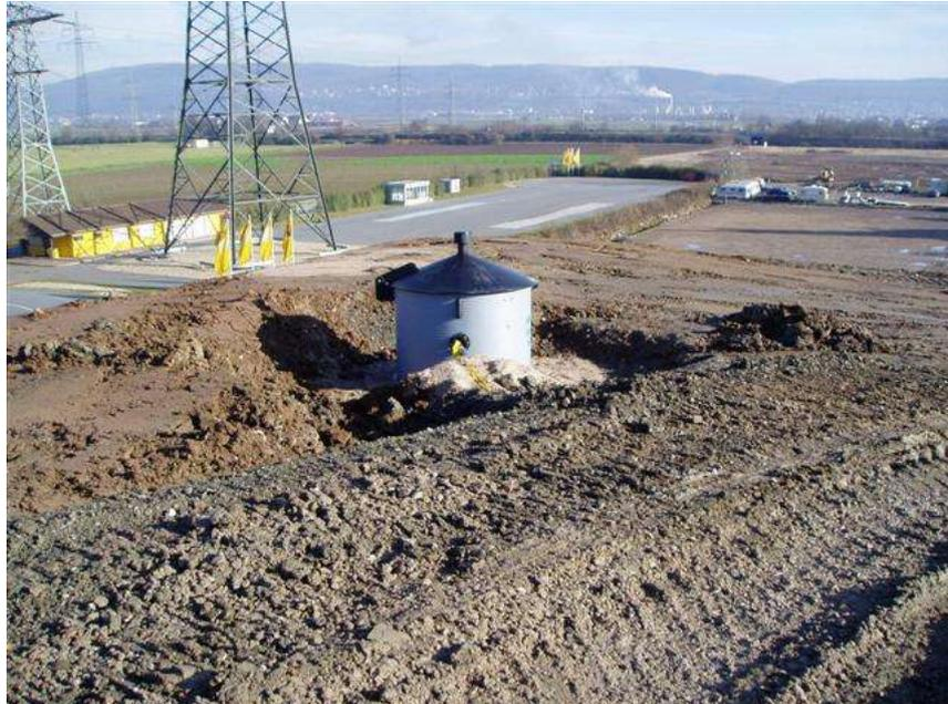
**Bild 3: Gasbrunnenkopfschacht auf dem Plateau des Westteils der Deponie**
