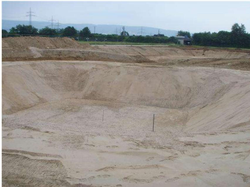
**Bild 11: ADAC-Speicherbecken mit einem Volumen von 1.000 m<sup>3</sup>**
