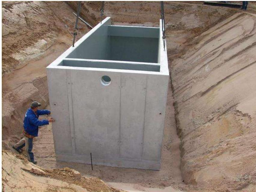
**Bild 9: Regenklärbecken für die Oberflächenwasserableitung der KAM-Fläche
