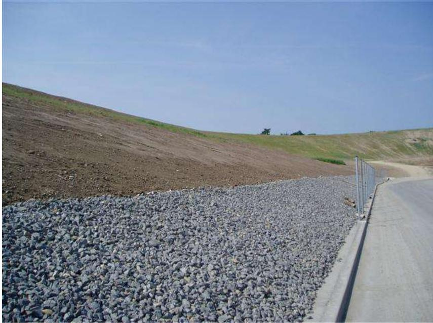
**Bild 21: Steinschüttung am Böschungsfuß im Eingangsbereich mit Entwässerungsmöglichkeit entlang der Bordsteine**
