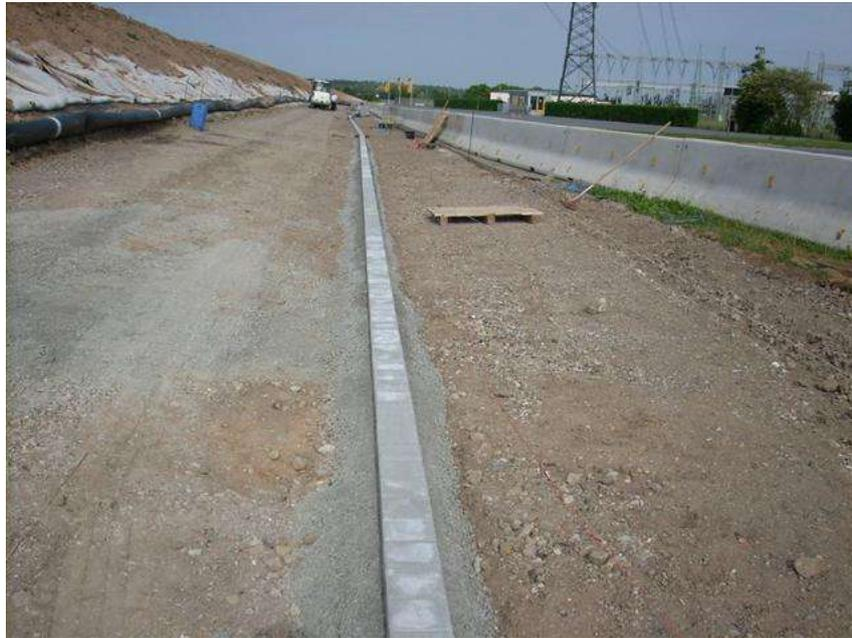
**Bild 15: Entwässerungsrinne entlang des ADAC in der Bauphase**
