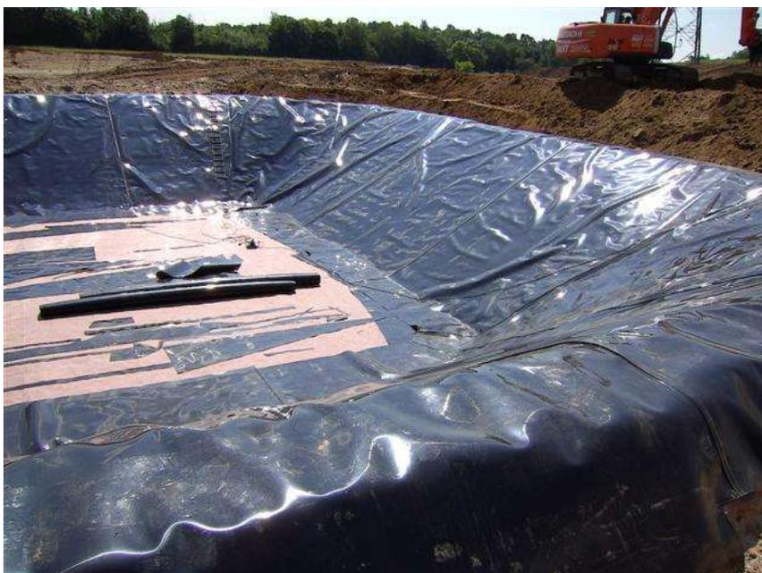
**Bild 12: ADAC-Speicherbecken, Abdichtung mit 1,5 mm PE-HD Bahn
