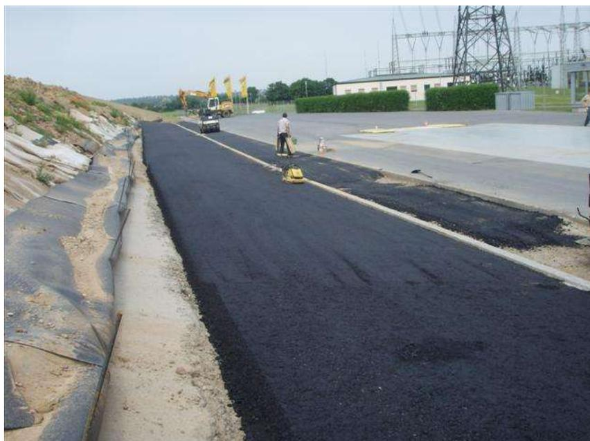
**Bild 16: Einbau der Asphaltdeckschicht als Oberflächenabdichtung am Rand zum Verkehrsübungsplatz des ADAC**
