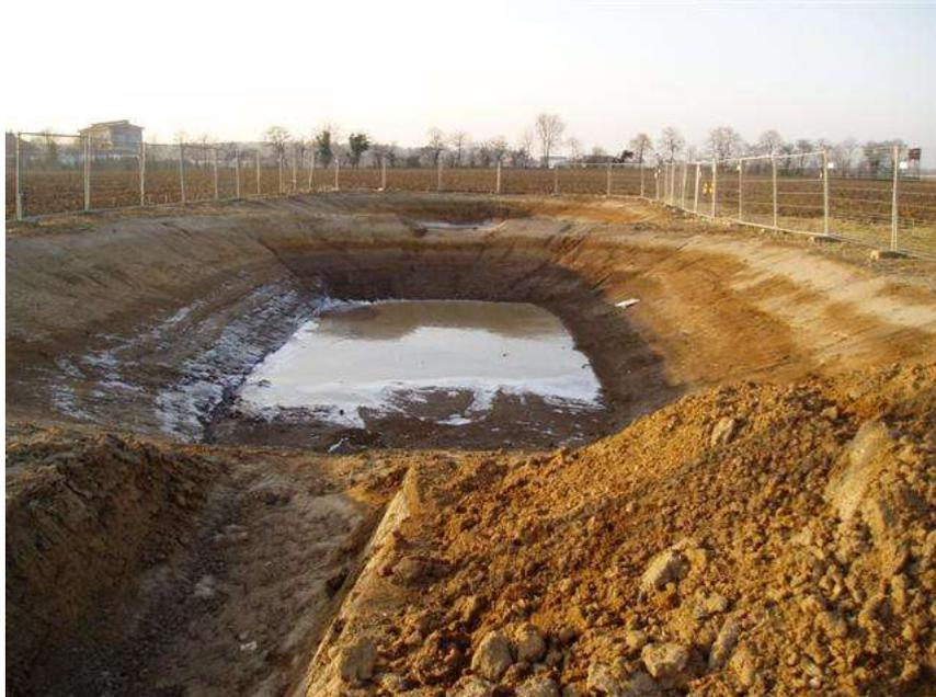
**Bild 7: Absetzbecken in der Bauphase**
