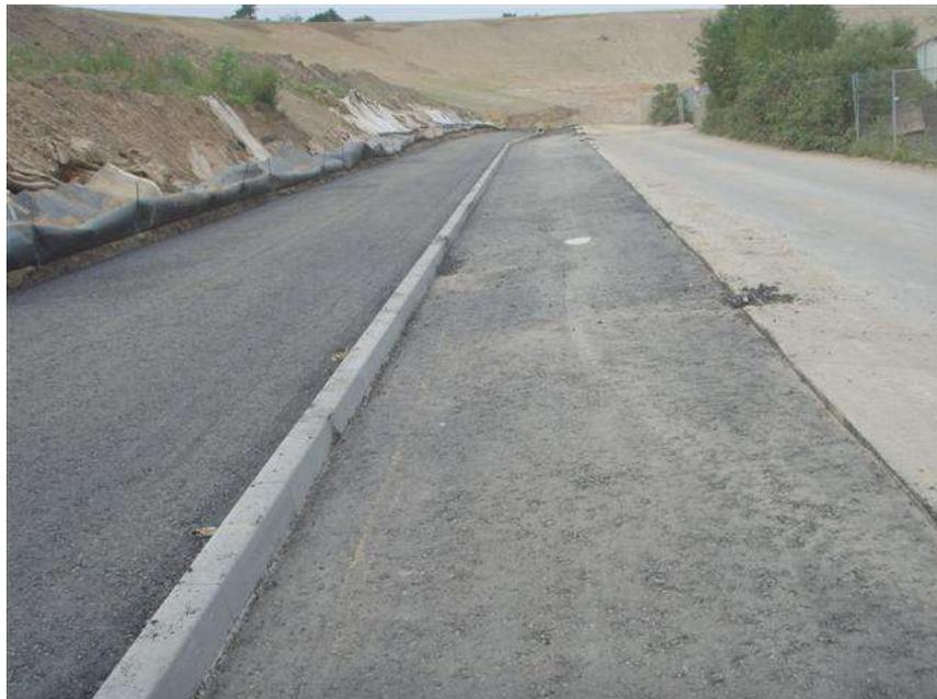
**Bild 18: Entwässerung im Eingangsbereich der Deponie –OK Tragschicht.
