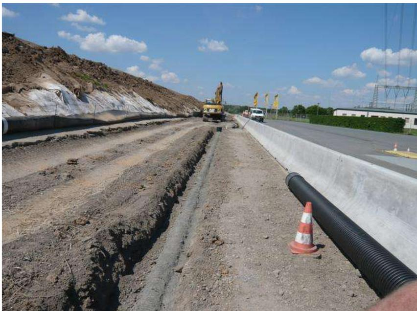
**Bild 14: Entwässerungskanal entlang des ADAC in der Bauphase
