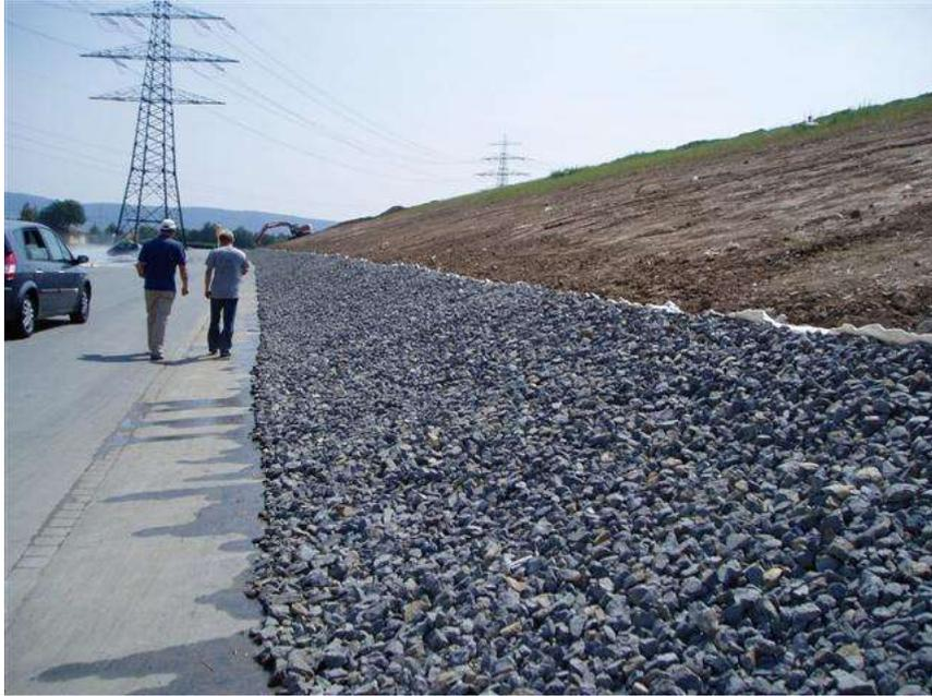
**Bild 17: Steinschüttung am Böschungsfuß entlang der ADAC-Fläche**
