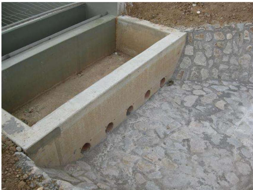
**Bild 10: Sandfilter hinter dem Regenklärbecken
