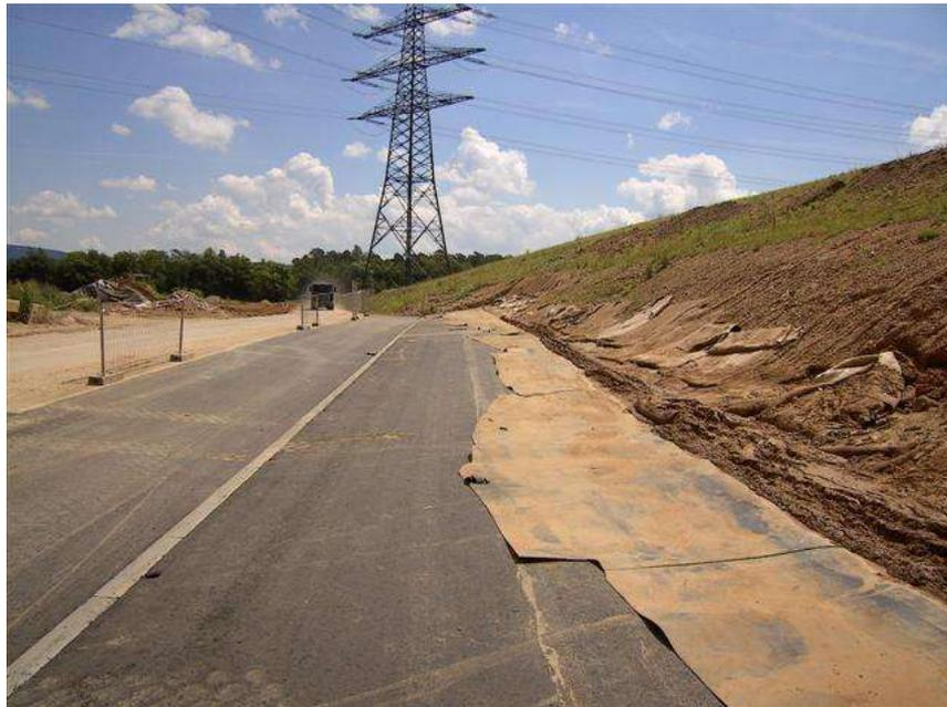
**Bild 19: Entwässerung im Eingangsbereich der Deponie- OK Deckschicht
