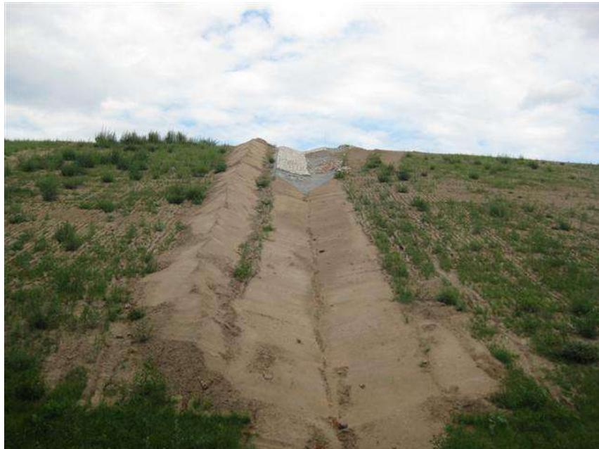
**Bild 22: Befestigte Entwässerungsmulde zur Ableitung von Oberflächenwasser von der Plateaufläche (Bauphase)**
