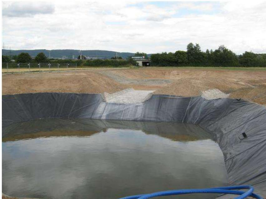
**Bild 13: ADAC Speicherbecken nach Teilfüllung mit Wasser**
