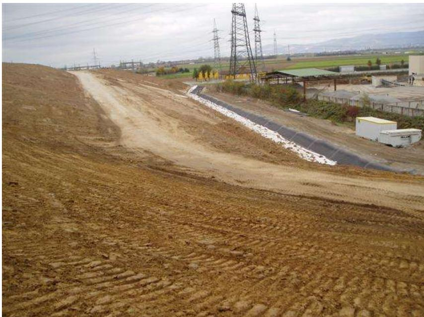
**Bild 8: Böschung Richtung KAM mit Entwässerungsgraben
