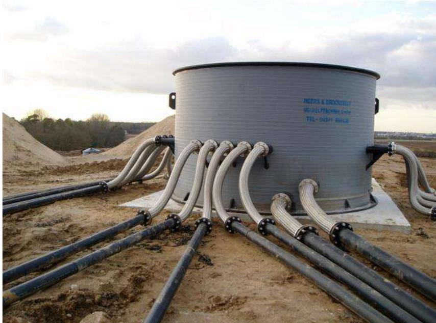
**Bild 1: Anschlüsse der Gasleitungen an die Gasunterstation**
