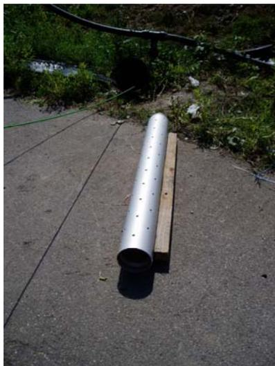
Der Vorteil der verwendeten „Kurzrohre“ liegt außerdem darin, dass diese auch über enge Endschächte eingezogen werden können. Die Wahl der Segmentlänge kann dem Schachttinnendurchmesser angepasst werden.
