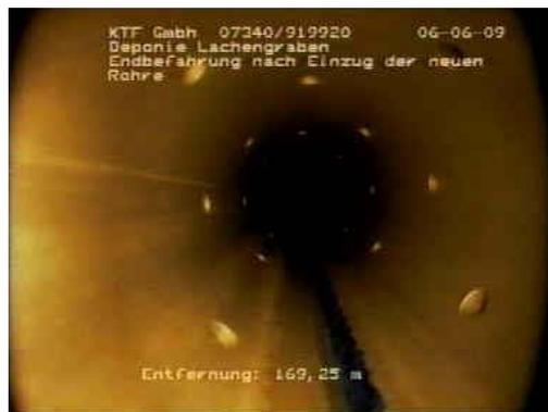
Die durchgeführte Verfahrenstechnik kann bei der Sanierung von Deponieentwässerungssystemen, insbesondere bei verformten und havariegefährdeten Leitungen aus PE, unter Betrachtung der spezifischen Randbedingungen das Mittel der Wahl sein. Der avisierte Einsatz von Stützrohren muss jedoch am speziellen Projekt zunächst einer Wirtschaftlichkeitsbetrachtung bzw. einer technischen Analyse unterzogen werden.
