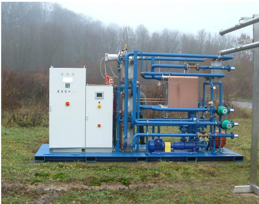
Abbildung 6: Provisorisch installiertes ORC Modul <sup>[4]</sup>
