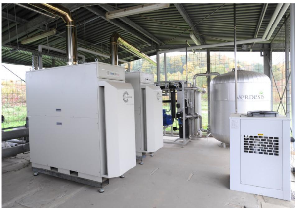
**Abbildung 5: Zwei Capstone Mikrogasturbinen mit Siloxanfilter (rechts) <sup>[4]</sup>**
