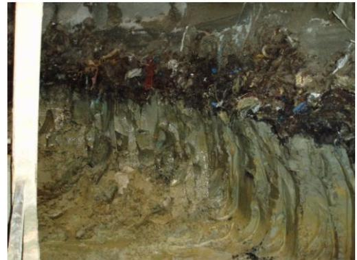
**Bild 5 bis 8: Abbaggern der Baugrubensohle und Aushub der geologischen Barriere**
