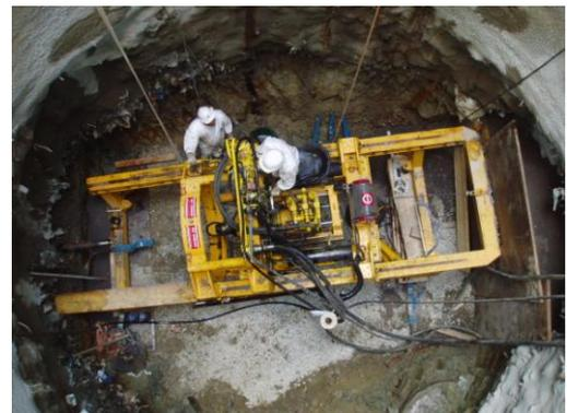
**Bild 18 bis 21: Einheben und Installieren des Bohrgetriebes**
