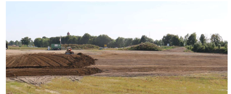
Verfüllung Gruben und Brüche, Deponie
