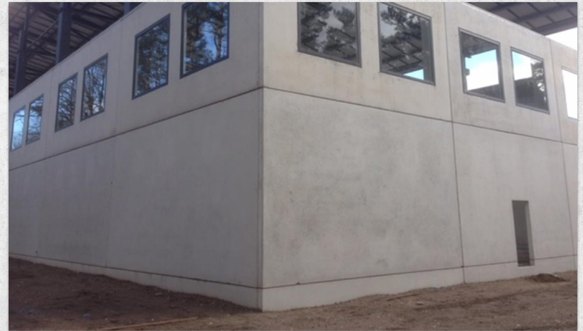
UND IM SELBSTVERSUCH EINE HALLE AUF UNSEREM GRUNDSTÜCK
