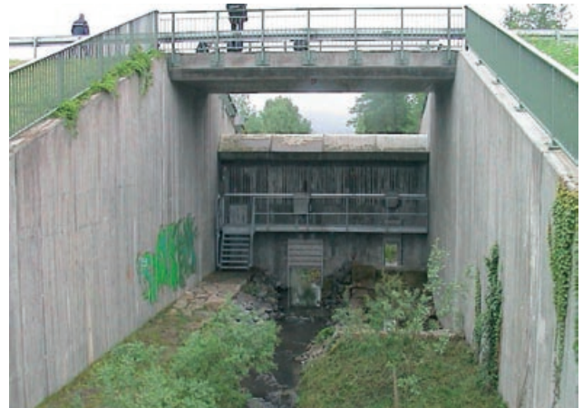
Abb. 4.23: HRB Stadtseebach, HWEA feste Schwelle im Durchlassbauwerk, Weinsberg
