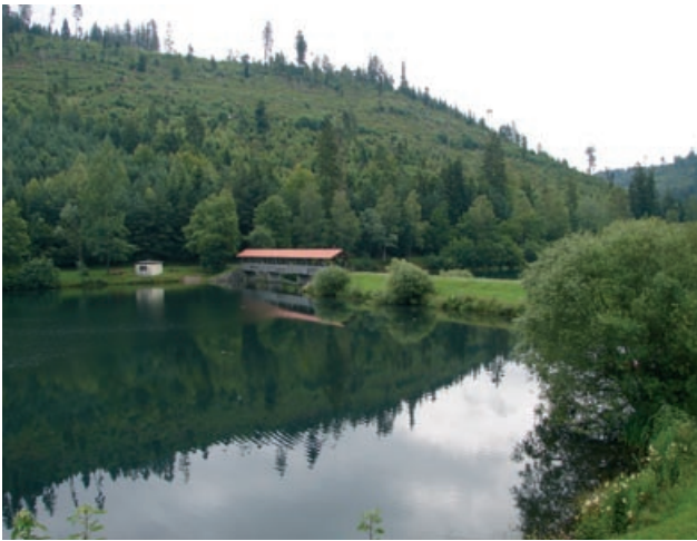
Abb. 4.104: Absperrbauwerk der Vorsperre der Nagoldtalsperre, Erzgrube
