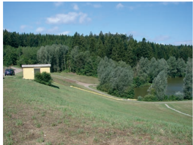
Abb. 4.97: HRB Götzenbach, Betriebsgebäude, Göggingen
