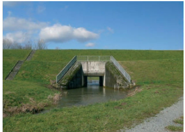
Abb. 4.82: HRB Mittleres Kinzigtal, Auslaufbauwerk (wasserseitig), Steinach
