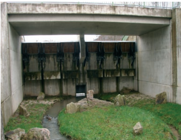
Abb. 4.20: Hochwasserentlastung mit selbst auslösenden, über Gegengewichte gesteuerte Holzklappen beim HRB Nr. 5 des ZV Baden-Baden/Bühl, Baden-Baden
