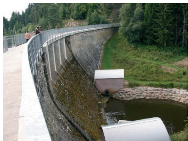
Abb. 4.18: Brännbach-Talsperre, Stirnentlastung (Bauwerksmitte) mit freiem Überfall in ein Tosbecken, Bräunlingen
