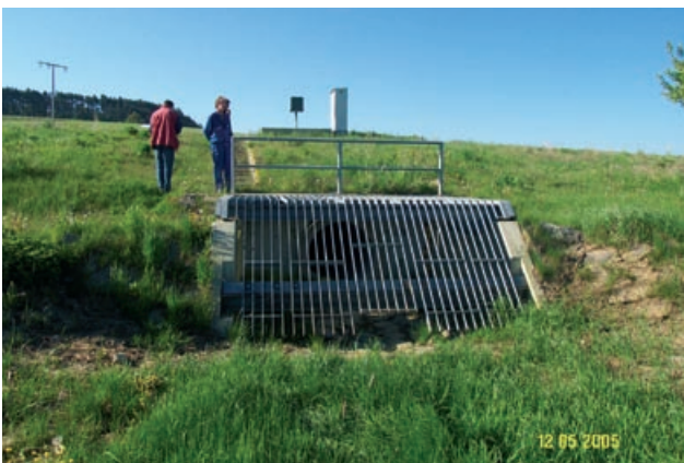
Abb. 4.66: HRB Augraben, Räumlicher Grobrechen mit Schlupf (Rechenmitte unten), Buchen
