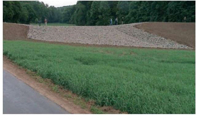
Abb. 4.27: HRB Binsenklinge, Dammscharte (kurz nach dem Bau), Sinsheim
