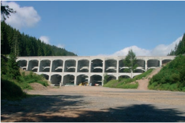
Abb. 4.6: Linachtalsperre, luftseitige Ansicht, Vöhrenbach
