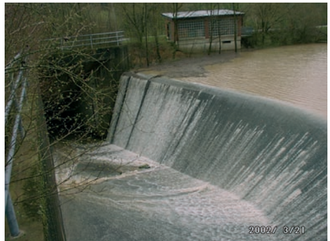
Abb. 4.35: HRB Michelbach, hydraulisch optimierter Einlauf steile Schussrinne durch den Damm, Pfaffenhofen
