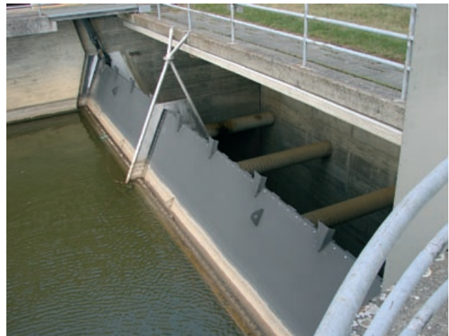
Abb. 4.16: Hochwasserentlastungsanlage des Stausee Buch, zweifeldrige Klappe, Rainau
