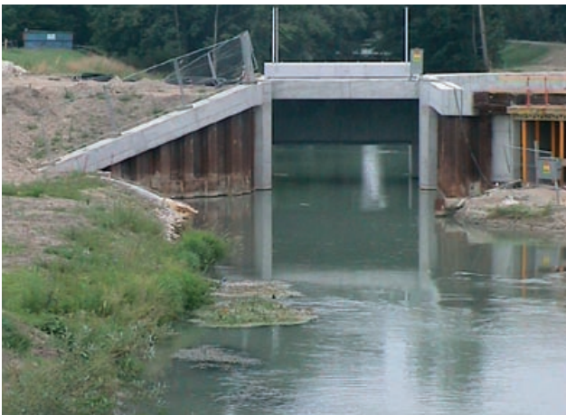
Abb. 4.85: Durchlass in einem Querdamm des Rückhalteraus Söllingen / Greffern (im Bau), Lichtenau
