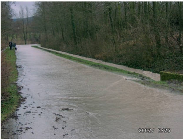
Abb. 4.42: HRB Nonnenbach, Flutmulde in Betrieb, Obersulm
