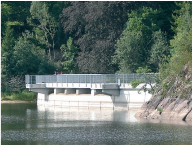
Abb. 4.19: Brändbach-Talsperre, HWEA Einlauf (Bauwerksmitte), Bräunlingen
