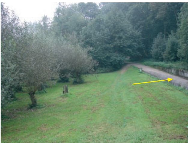
Abb. 4.40: HRB Katzenbach, links Bäume als Grobrechen, rechts Überlaufschwelle, Pfaffenhofen
