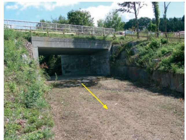
Abb. 4.24: HRB Federbach, Beginn der Schusrinne (von Luftseite aus), Göggingen
