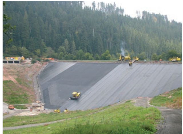
Abb. 4.9: Sanierung der Asphaltaußendichtung der Nagoldtalsperre 2002, Erzgrube
