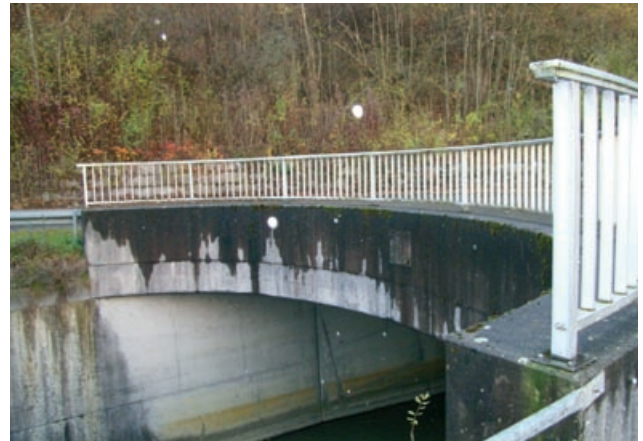
Abb. 4.107: Geländer als Absturzsicherung beim Auslassbauwerk der Schlichemtalsperre, Schömberg
