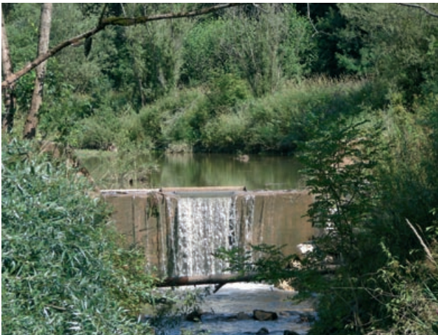
Abb. 4.105: HRB Götzenbach, Geschiebesperre im Zulauf, Göggingen
