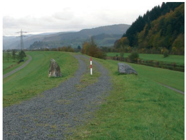
Abb. 4.118: HRB Mittleres Kinzigtal Absperrung des Damms für große Fahrzeuge, Steinach
