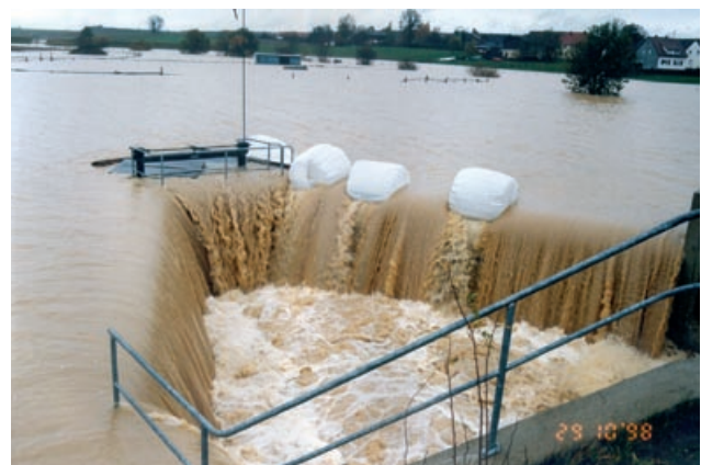
Abb. 4.44: HRB Mühlgraben, Schachteinlauf bei Hochwasser mit Treibgut, Unterschneidheim
