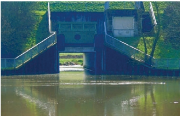
Abb. 4.83: HRB Mittleres Kinzigtal, Segmentverschluss des Auslaufbauwerks (luftseitig), Steinach
