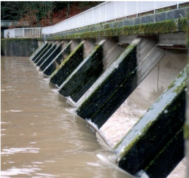
Abb. 4.15: Einlauf Hangseiteneinleitung Nagoldtalsperre, Hochwasser 1993, Erzgrube
