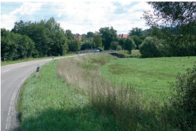
Abb. 4.12: HRB Marbach, luftseitige Ansicht des Seitendamms mit Straße, Villingen-Schwenningen
