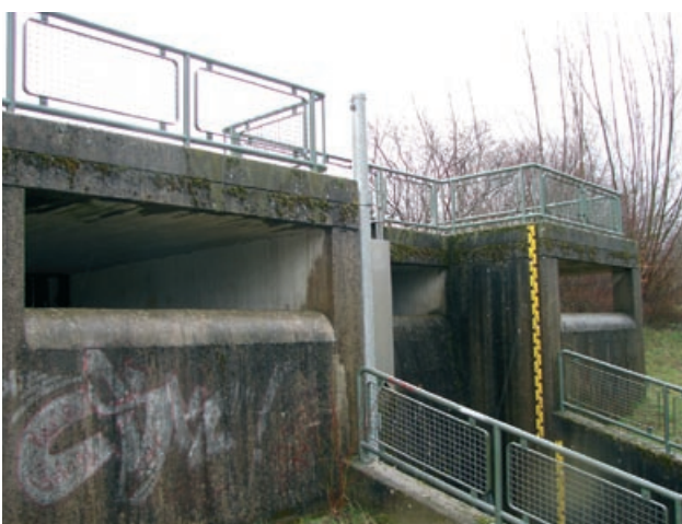
Abb. 4.43: HRB Hatzengraben, Schachteinlauf am Absperrbauwerk, Karlsruhe-Grünwettersbach
