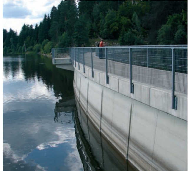
Abb. 4.4: Brändbachtalsperre, gekrümmte Gewichtsstauwand, Bräunlingen
