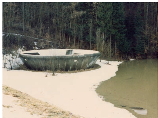
Abb. 4.46: HRB Beimbach, Einlauftrichter, Rot am See
