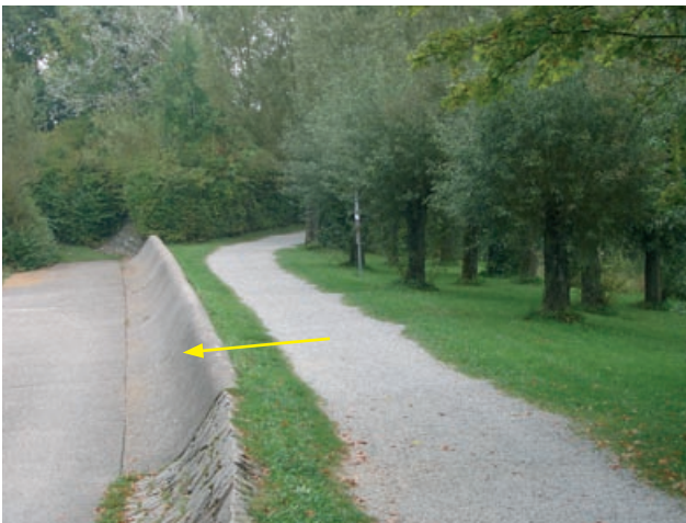
Abb. 4.38: Breitenauer See, Überlaufschwelle und links Flutmuldenbeginn, Obersulm
