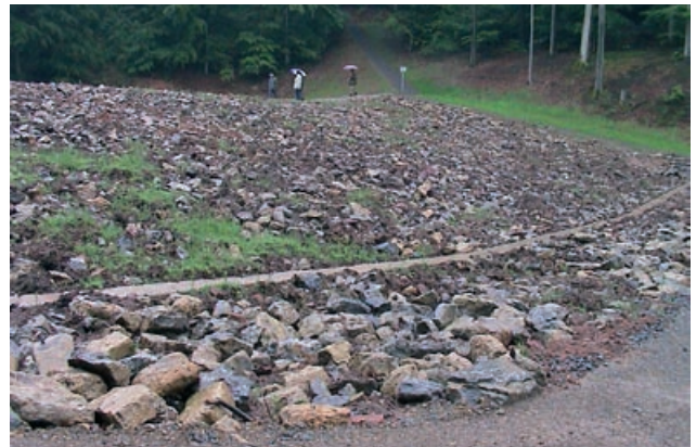
Abb. 4.28: HRB Haager Tal, überströmbarer Damm (Steinschüttung), Schönbrunn
