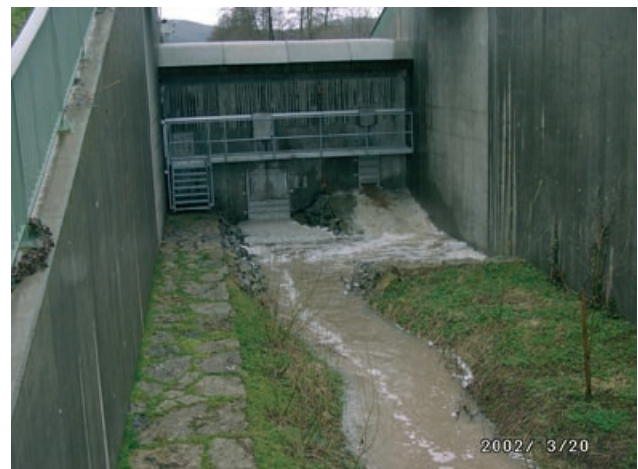
Abb. 4.55: HRB Stadtseebach, offener Durchlass mit zwei Schiebern und HWEA (freier Überfall), Weinsberg
