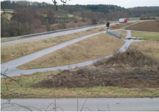
Abb. 4.11: HRB Kleingartach, Absperrbauwerk als Straßendamm ausgebaut, Eppingen
