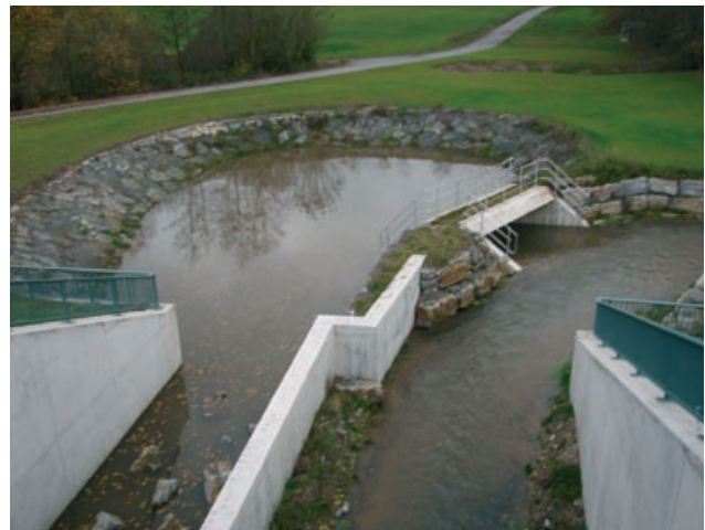
Abb. 4.91: HRB Bretzfeld Nr. 3, löffelfartiges Tosbecken beim Betriebsauslass, rechts Ökogerinne, Bretzfeld
