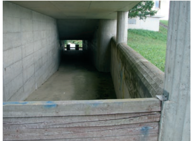
Abb. 4.33: HRB Stockmühle, Blick in Fortleitungsbauwerk, strömungsgünstigere runde Überlaufkante, Westhausen
