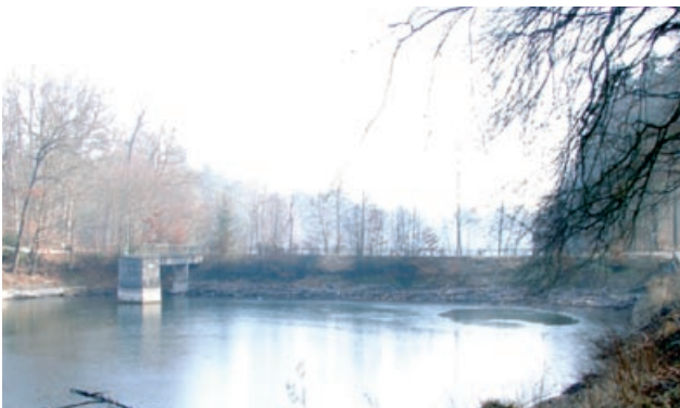
Abb. 3.8: Neuer See, Absperrdamm zum dahinter liegenden Pfaffensee, Stuttgart
