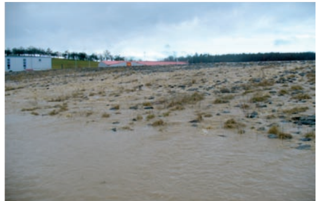
Abb. 4.29: HRB A21, überströmter Damm, Aglasterhausen
