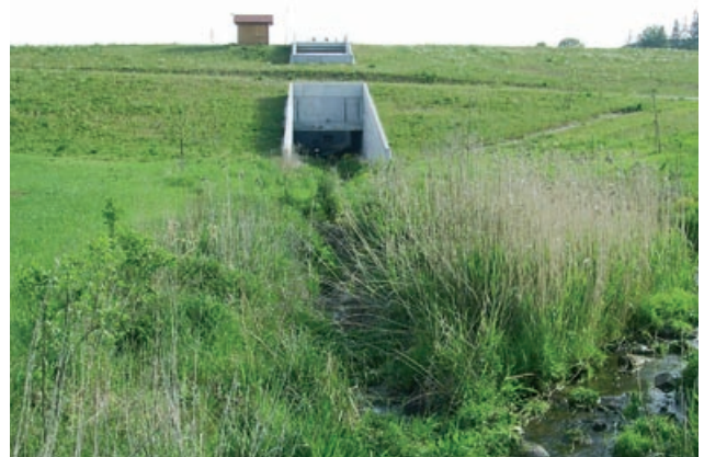
Abb. 4.59: HRB Tonnenberg, bei den Wegen geschlossene Bauweise, Lauchheim
