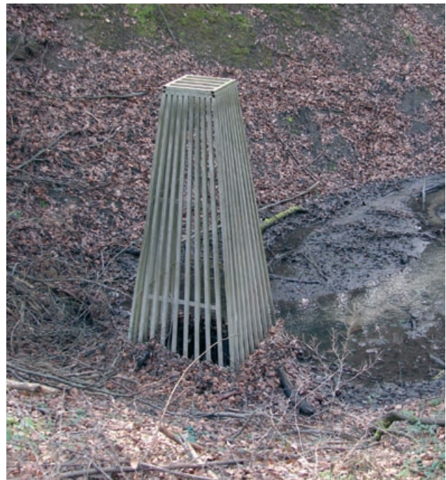
Abb. 4.67: Turmrechen (Verkläusungsgefahr)
