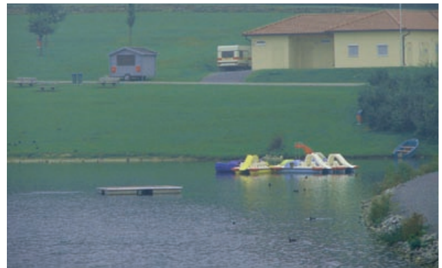
Abb. 4.123: HRB Ehmetsklinge, Badebereich und Sanitärgebäude, Zaberfeld
