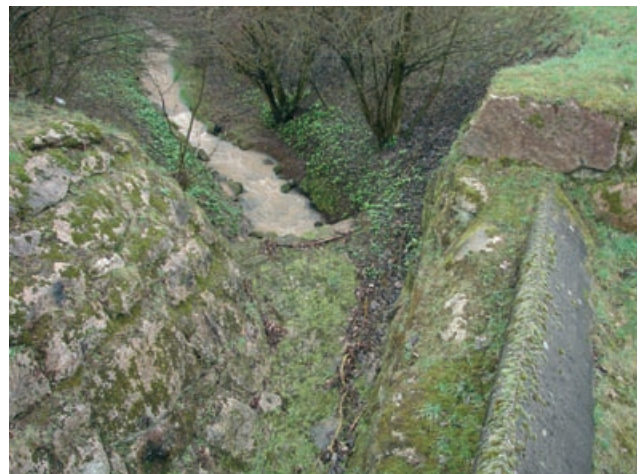
Abb. 4.81: HRB Nr. 15, wird die Abflussleistungsfähigkeit des Durchlasses überschritten wird dieser eingestaut. Bei entsprechender Einstauhöhe wird nach rechts über die Schwelle in das HRB entlastet, Sinsheim
