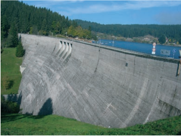
Abb. 4.3: Schluchsee-Talsperre, Gewichtsstauwand, Schluchsee
