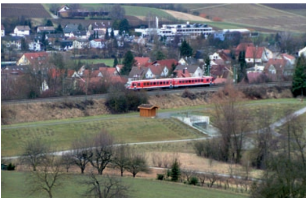
Abb. 4.13: HRB Sülzbach, Absperrbauwerk vor Eisenbahndamm, Obersulm
