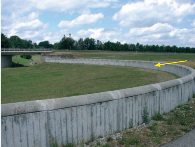
Abb. 4.36 HRB Schwabsberg, lange Überlaufschwelle, Rainau
