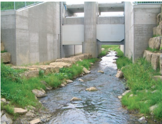
Abb. 4.50: HRB Oberes Wiesental, links der Betriebsauslass, rechts der Gewässerkorridor, Billigheim
