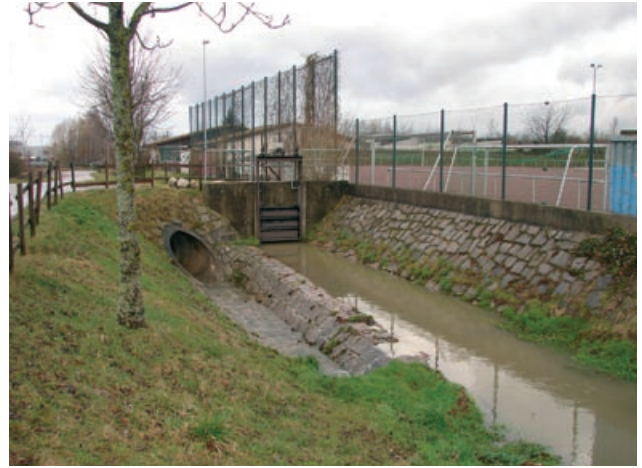
Abb. 4.80: HRB Nr. 10, Entlastung nach links, Bühl
