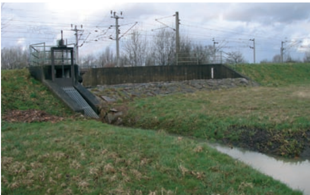
Abb. 4.84: HRB Nr. 10, Auslauf und HWEA, der Abfluss muss unter der Bahnlinie abgeführt werden, Bühl
