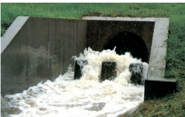
Abb. 4.90: HRB Nord-West, Zahnschwelle, Freiburg
