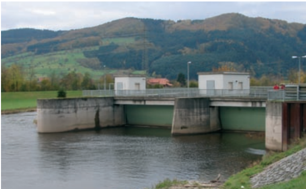
Abb. 4.78: HRB Mittleres Kinzigtal, Einlaufbauwerk, Steinach
