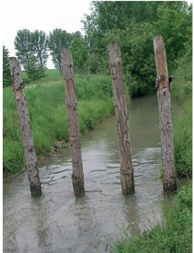
Abb. 4.63: HRB Raußmühle, Grober Vorrechen, Eppingen
