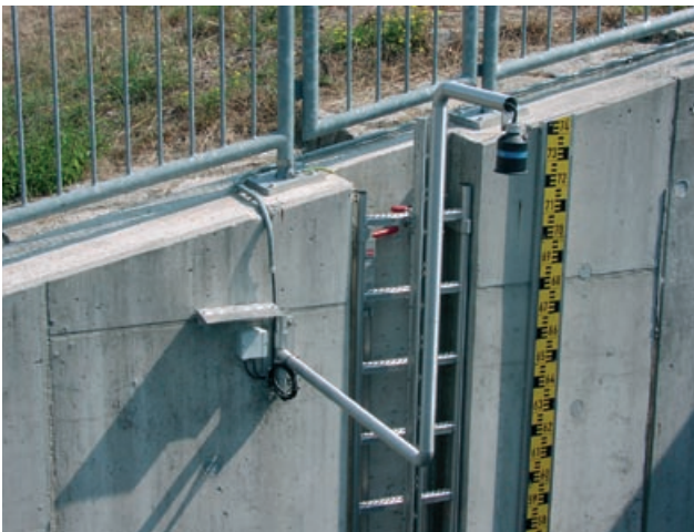
Abb. 4.100: Ultraschall-Wasserspiegelmessgerät
