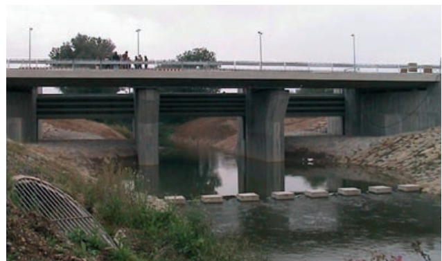
Abb. 4.93: HRB Schorndorf/Winterbach, löffelfartiges Tosbecken mit Zahnschwelle, Winterbach
