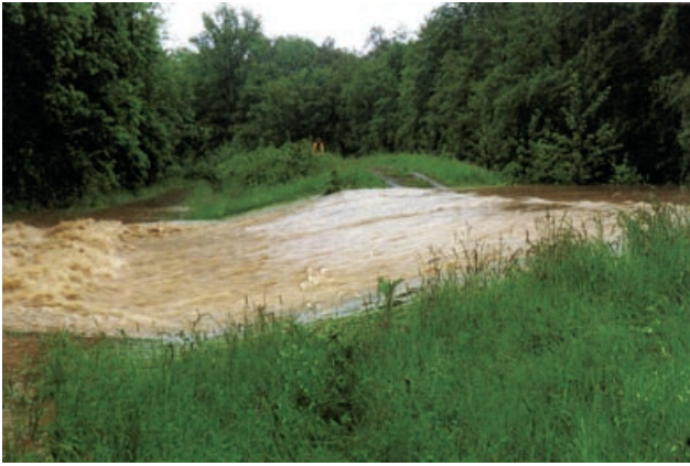
Abb. 4.31: HRB Nord, 1983 Dammscharte im Einsatz, Freiburg
