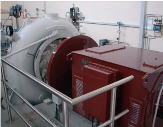
Abb. 4.120: Turbine und Generator der Nagoldtalsperre, Erzgrube
