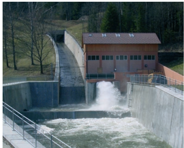
Abb. 4.17: Schussrinne und Tosbecken (rechts Betriebsauslass in Betrieb), Nagoldtalsperre, Erzgrube
