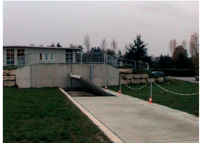
Abb. 4.11: HRB Kleingartach, Absperrbauwerk als Straßendamm ausgebaut, Eppingen
