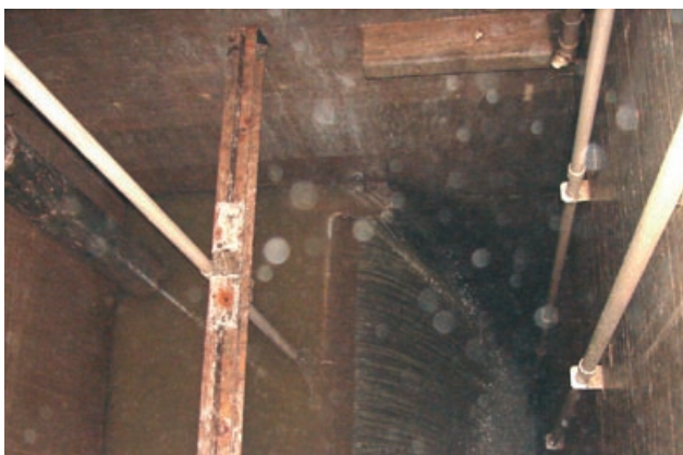
Abb. 4.54: HRB Götzenbach, Blick auf die Stauwand im Mönchbauwerk, Göggingen
