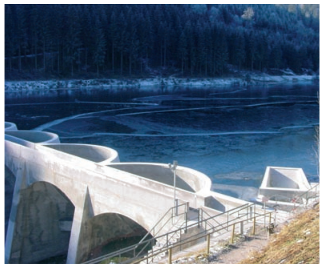
Abb. 4.5: Linachtalsperre, Gewölbereihen, Vöhrenbach
