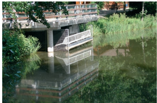
Abb. 4.69: Durchlass mit Schwimmrechen, Salinen-See, Bad Dürkheim
