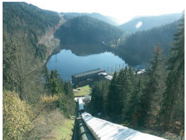
Abb. 4.119: Kraftwerk Häusern mit Schwarza-Becken, Zulauf über Stolten und Rohrleitung aus dem Schluchsee, Häusern
