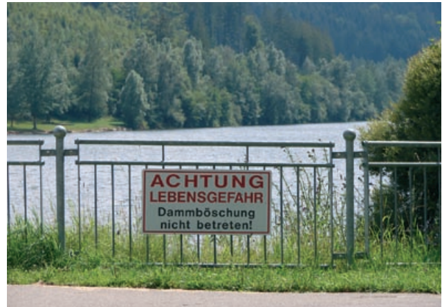
Abb. 4.112: Warnschild, Nagoldtalsperre, Erzgrube
