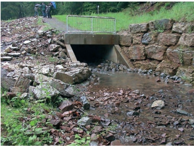
Abb. 4.60: HRB Haager Tal, geschlossener Durchlass (luftseitig), Schönbrunn
