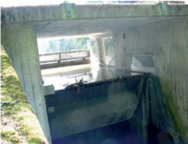
Abb. 4.21: Regulierbare Hochwasserentlastung durch Klappe, Unterwasser Salinen-See, Bad Dürkheim
