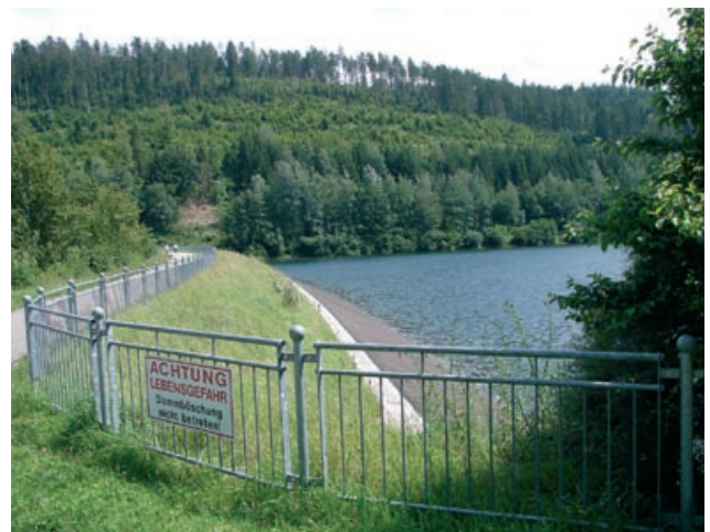
Abb.: 4.108: Geländer bei der Nagoldtalsperre, Erzgrube
