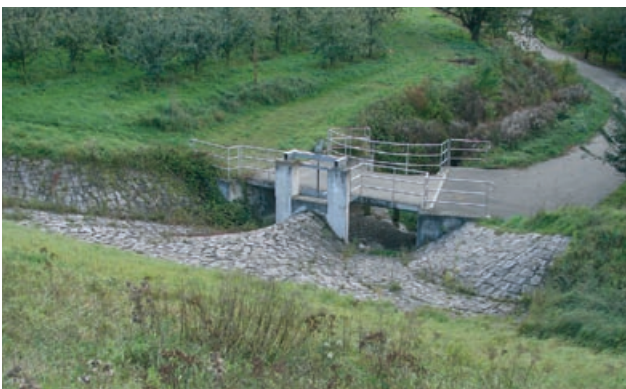
Abb. 4.62: HRB Untere Niedermatten, Steuerschieber des Durchlasses luftseitig, rechts und links die befestigten Rinnen der Hochwasserentlastungsanlage, Vogtsburg am Kaiserstuhl
