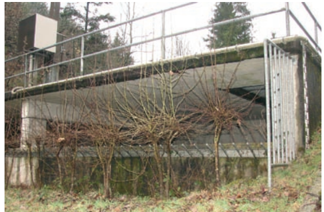
Abb. 4.74: HRB Nr. 1, kurze horizontale Stäbe unterhalb der Überlaufschwelle sollen aufschwimmendes Geschwemmsel zurückhalten, dornige Büsche neugierige Besucher, Baden-Baden
