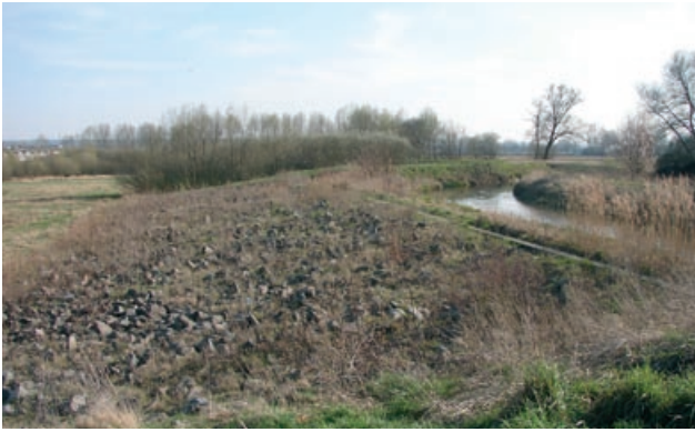
Abb. 4.76: Überlaufstrecke beim Kriegbachpolder, Wasserstand durch Schützenanlage im Unterwasser geregelt, Waghäusel
