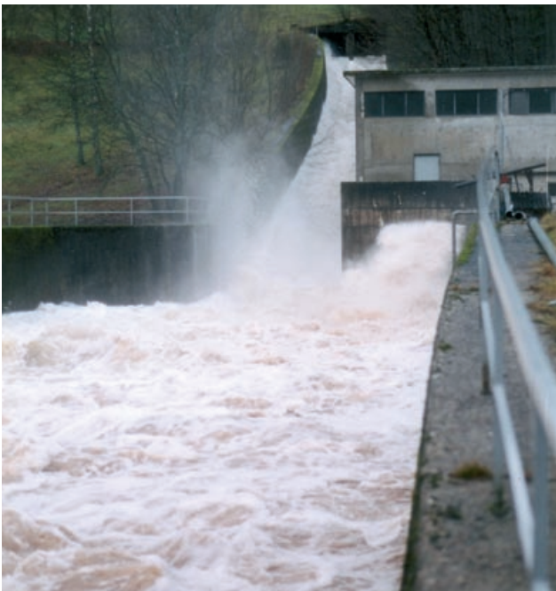
Abb. 4.89: Nagoldtalsperre, Schussrinne (links) und Tosbecken im Entlastungsfall, Erzgrube
