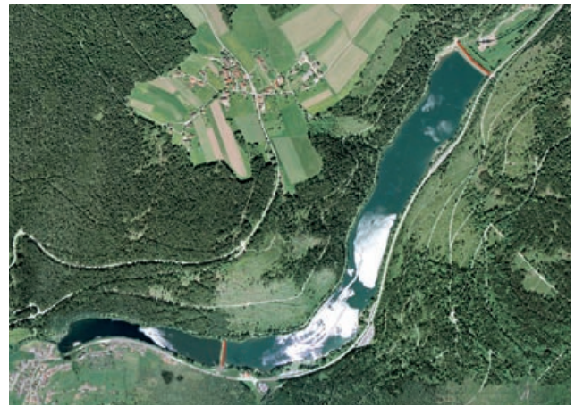
Abb. 3.16: Nagoldtalsperre, rechts Hauptsperrre links Vorsperre, Ab-sperrbauwerke als rote Linie dargestellt (RIPS-Pool BW), Erzgrube
