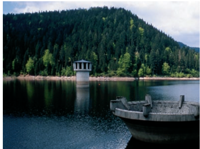
Abb. 4.51: TSP Kleine Kinzig, Trinkwasserentnahmeturm (links), Hochwasserentlastung (rechts), Alpirsbach
