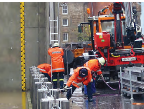
Feuerwehrleute errichten einen Hochwasserschutzwall
