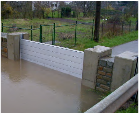
Hochwasserschutz vor einer Einfahrt
