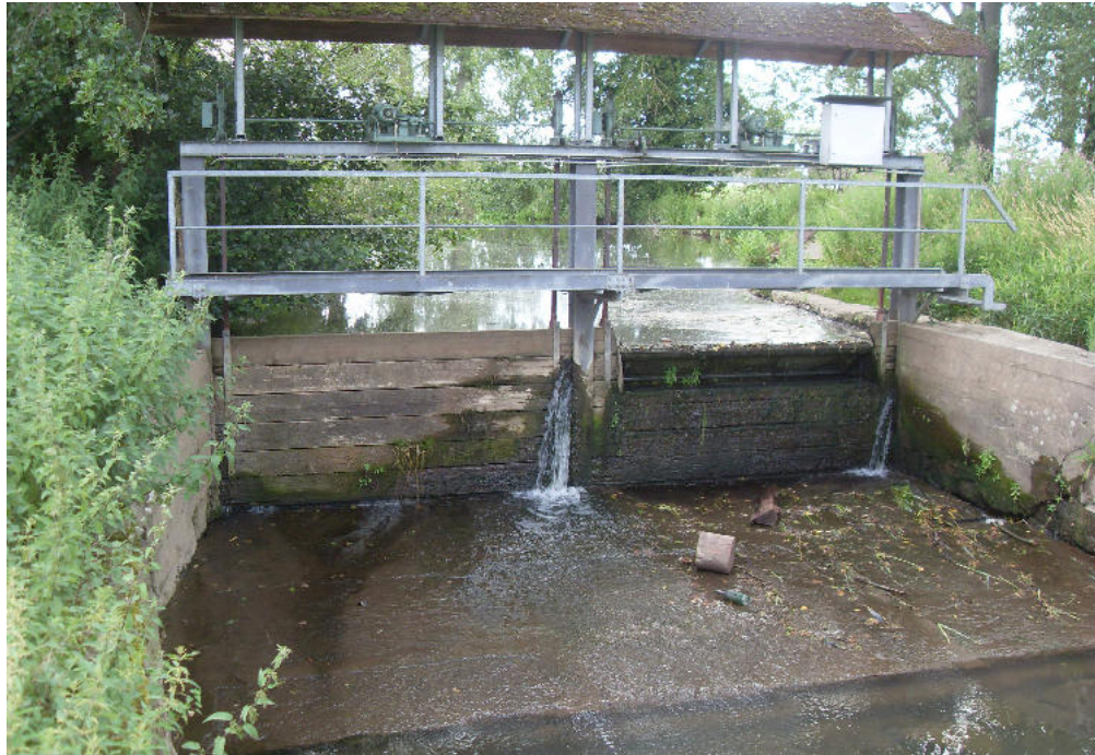
Bild 30: Wehr an der Rohrburger Mühle im Schutterabschnitt zwischen Müllen und Kittersburg. Dieses Wehr ist für den Bitterling ( Rhodeus sericeus amarus ) [1134] und andere Wirtsfische der Kleinen Flussmuschel ( Unio crassus ) [1032] aktuell nicht durchwanderbar. Es existieren keine Auf- bzw. Abstiegshilfen. Der Staubereich ist für die Kleine Flussmuschel nicht besiedelbar.
