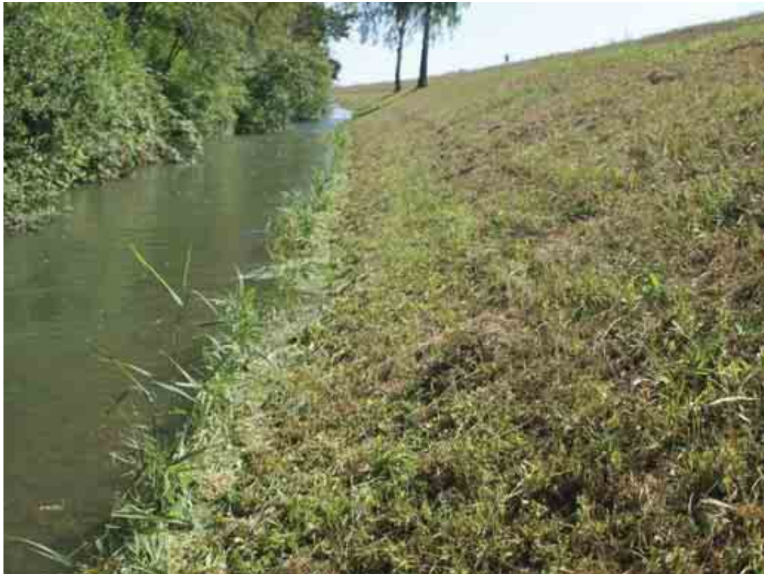
Abbildung 23: Das intensive Mulchen der Böschungen des Rheinseitengrabens bis ins Wasser hinein stellt eine starke Beeinträchtigung der Lebensstätte der Helm-Azurjungfer ( Coenagrion mercuriale ) [1042] dar. Holger Hunger. 16.07.2014.
