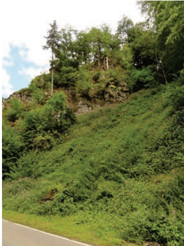
Bild 35: Im Zuge von Verkehrssicherungsmaßnahmen freigestellte Hänge im Wehratal M. Sonnberger, 12.8.2011
