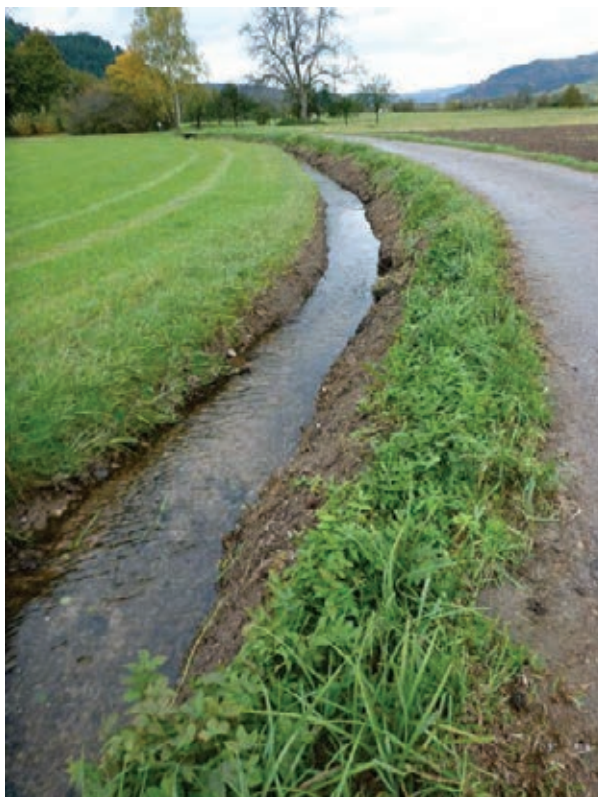
Bild 18: Sohlenräumung am Niederbach, die zukünftig zur Schonung der Vorkommen der Kleinen Flussmuschel nur abschnittsweise durchgeführt werden sollte. Peter Rudolph, 02.11.2012
