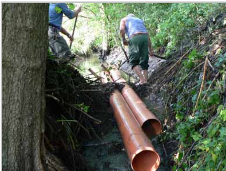
Am Eulengraben im Kronenried wird der Wasserstand bei zwei Biberdämmen mittels Drainagerohren abgesenkt, um Überflutungen der angrenzenden landwirtschaftlichen Nutzflächen zu verhindern.
