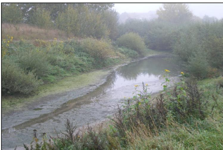
Bild 14: „Marena-Schlut“ bei der A 6-Brücke Zustand am 16.10.08 (5 Jahre nach Fertigstellung). Das Bild zeigt die starke Verschlammung, das Restwasser ist bereits völlig vom Altneckar abgeschnitten. Die Sohle ist mit einer bis zu 80 cm dicken Schlammschicht bedeckt. Als Laichplatz für Meer- oder Flussneunaugen ist die Schlut in diesem Zustand nicht geeignet.
