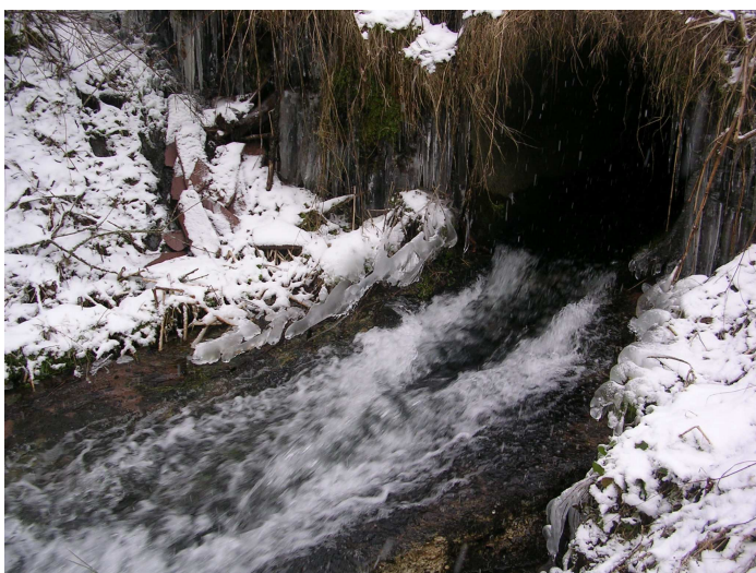
Bild 10: Rötenbächle, Verrohrung unterhalb Strohloch Frank Pätzold, 07.01.2010
