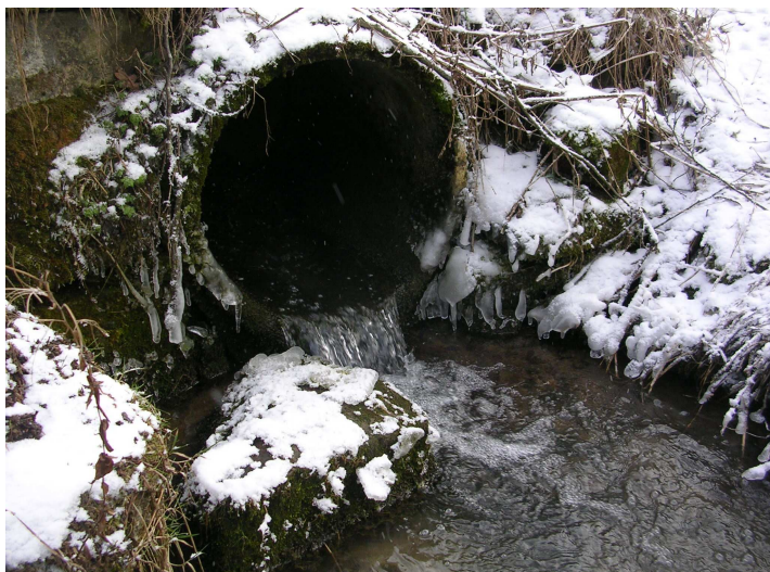
Bild 7: Verrohrung Heftenbach Frank Pätzold, 07.01.2010
