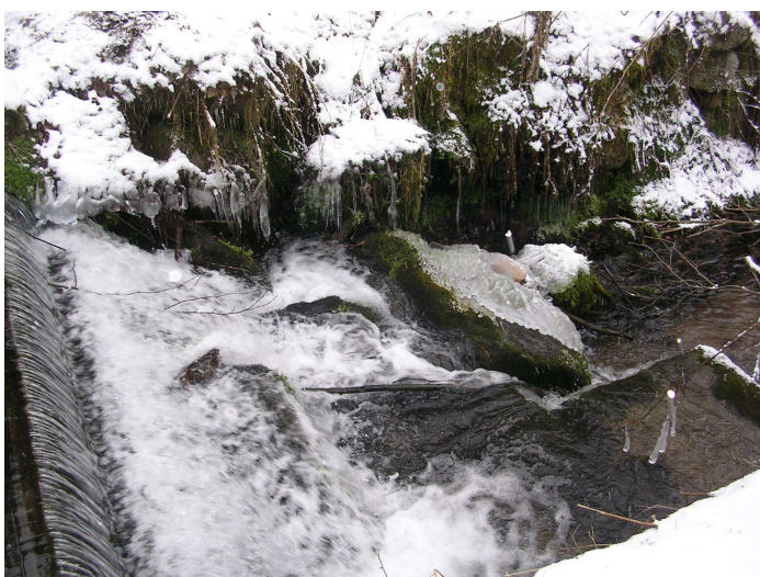
Bild 11: Rötenbächle, Querbauwerk unterhalb Strohloch Frank Pätzold, 07.01.2010
