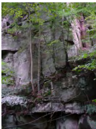
Abbildung 19: Lebensraumtyp [8220], Silikatfelsen mit Balmen (LRT [8310]), Buntsandstein-Felswand in einem ehemaligen Steinbruch (WEDLER)
