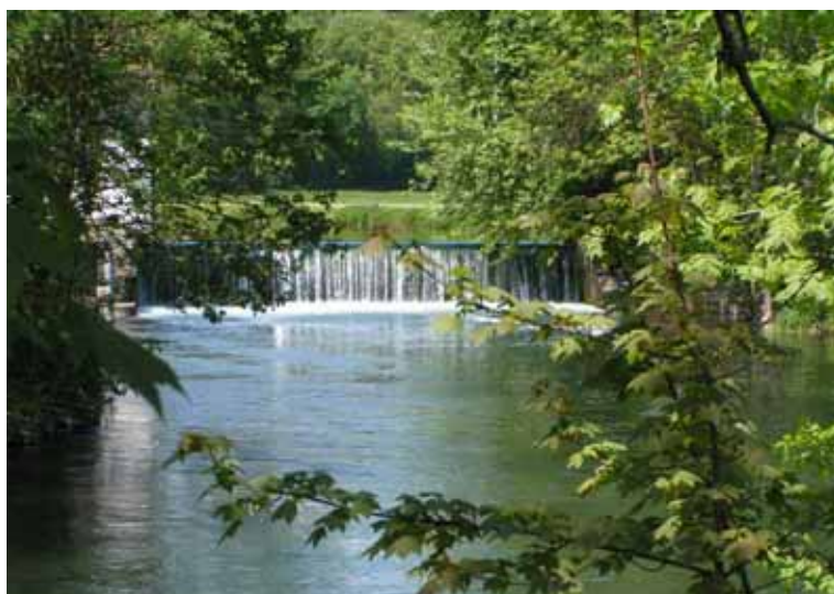
Bild 5: Querbauwerke wie dieses Wehr an der Bindsteinmühle (Teilgebiet 10) beeinträchtigen die Durchgängigkeit des Fließgewässers.
