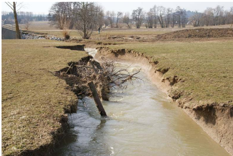
Bild 28: Renaturierter Abschnitt der Schneidheimer Sechta. Zur Verbesserung der dynamischen Prozesse im Gewässer eingebrachtes Totholz. Foto: K. Böger, 18.03.2010
