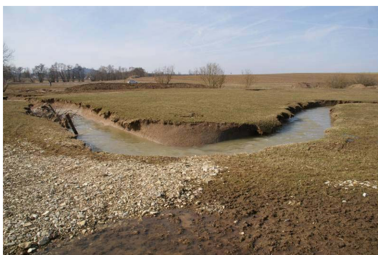
Bild 27: Renaturierter Abschnitt der Schneidheimer Sechta. Im Vordergrund erkennt man das zur Habitatverbesserung der Bachmuschel eingebrachte Kiesmaterial. Ufer sind durch Hochwasser bereits unterspült. Foto: K. Böger, 18.03.2010
