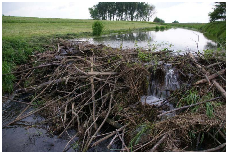
Bild 16: Biberdamm östlich Sechtenhausen unterhalb Achbachmündung. Der Biber staut das Gewässer, um Wohnburgen anlegen zu können, deren Eingänge unter Wasser liegen. Foto: K. Böger, 08.05.2009
