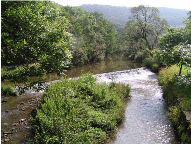
Bild 4: für Fische nicht durchgängiges Wehr oberhalb der Bühler- Mündung in den Kocher bei Geislingen, mit geringer Fallhöhe. Foto: C. Vogt-Rosendorff, 30.06.2009.
