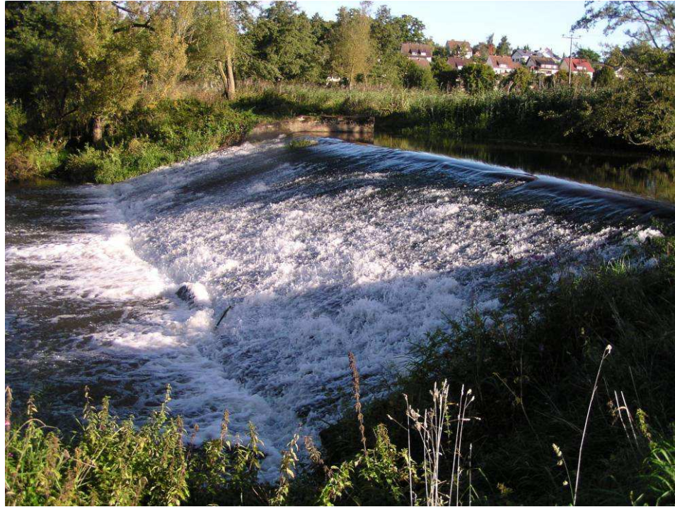
Bild 9: Wehre wie hier bei Stimpfach tragen zur geringen Fließgeschwindigkeit der Jagst bei und beeinträchtigen die Durchgängigkeit für Gewässerorganismen. C. Vogt-Rosendorff, 16.09.2010
