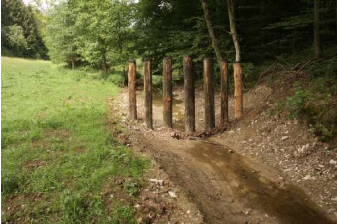
Bild 34: Beeinträchtigen der Groppenlebensstätte am Aschbach. Der Einbau einer steinig-kiesigen Gewässersohle hätte den Eingriff gemindert und das Gewässer wäre wieder durchgängig besiedelbar.
