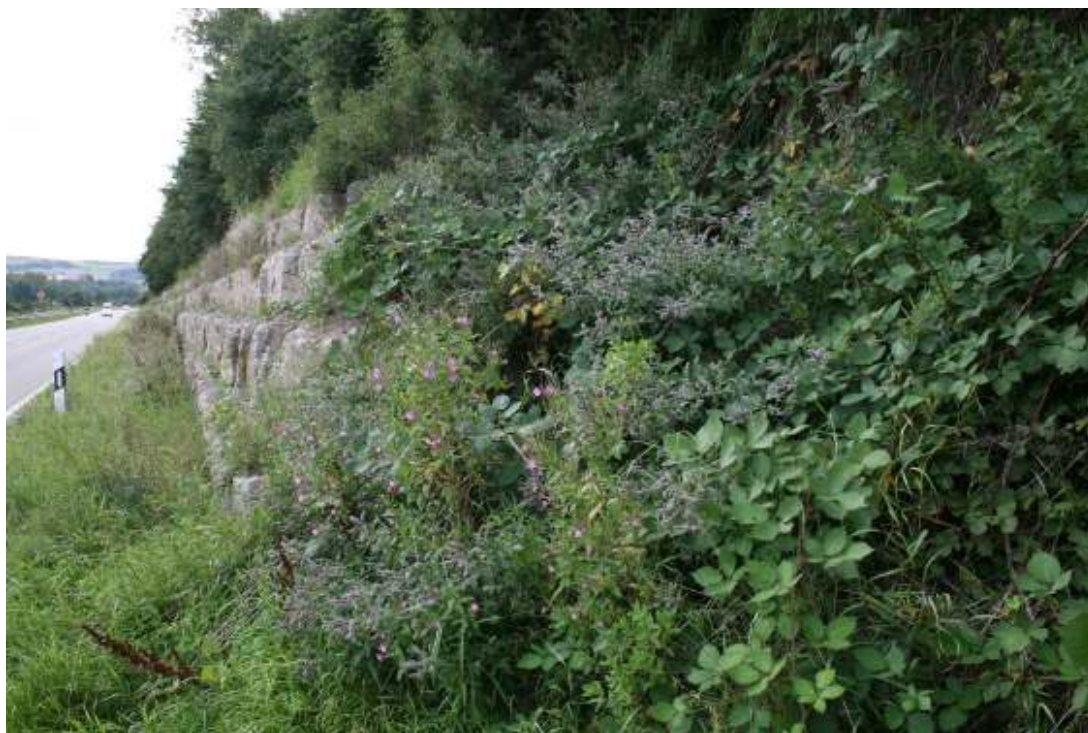
Bild 20: Die Kalktuffquelle [7220*] zwischen Markelsheim und Elpersheim ist aufgrund der hochwüchsigen Vegetation, die sie umgibt, kaum erkennbar. M. Röhl, 11.08.2011
