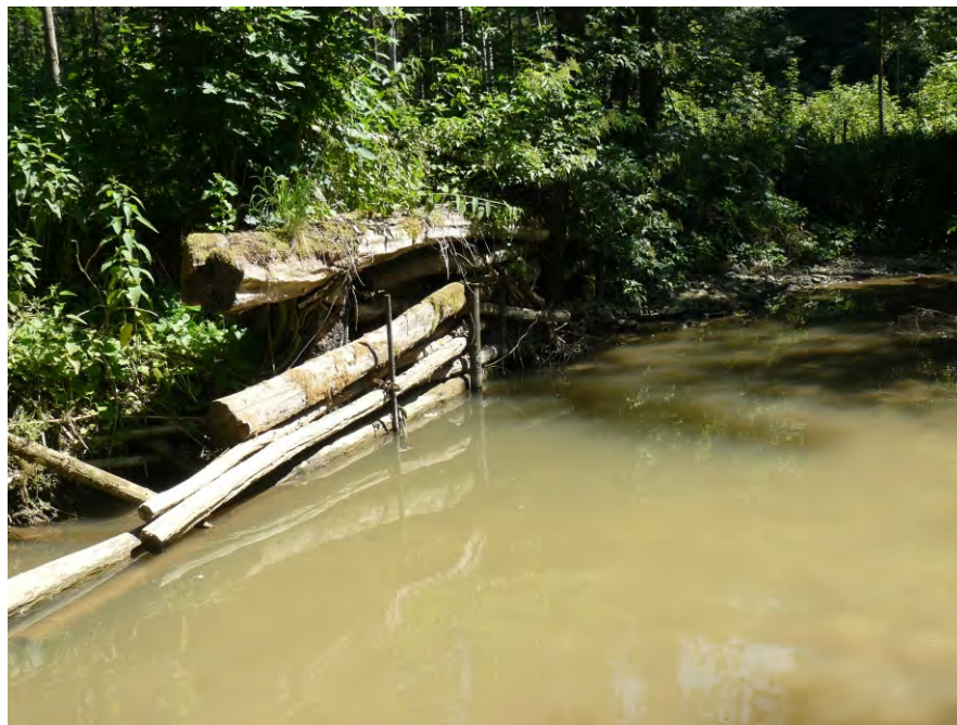
Bild 11: Uferverbau mit Holz an der Sall südöstlich von Orendelsall C. Andres, 27.06.2011
