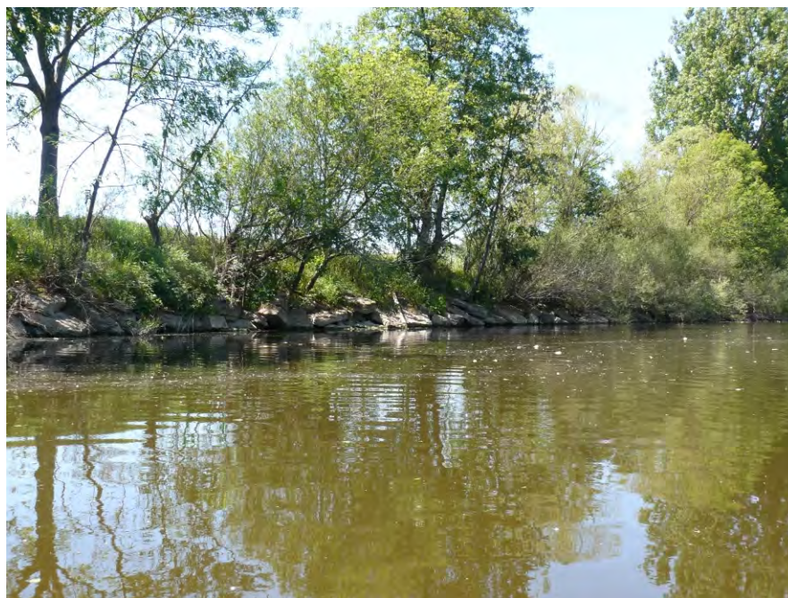
Bild 7: Uferverbau mit Steinen am Kocher zwischen Forchtenberg und Ernsbach C. Andres, 31.05.2011
