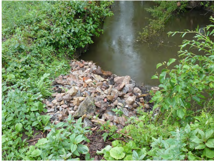
Bild 9: Neue Steinschüttung an einem Prallhang der Brettach westlich von Gedelsbach C. Andres, 01.06.2011
