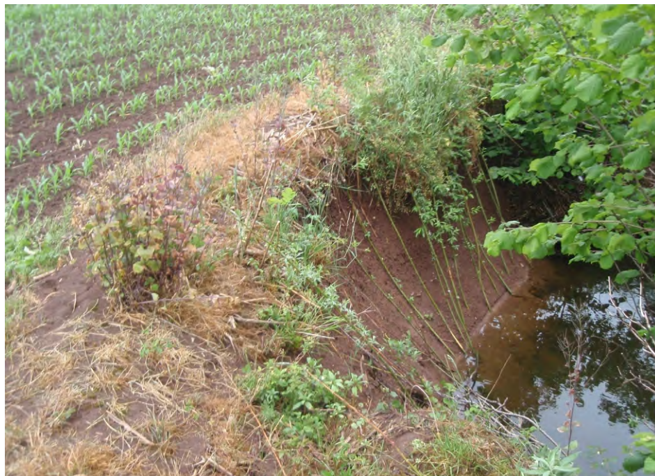
Bild 10: Maisanbau und Herbizideinsatz bis nahe an das Ufer der Ohrn westlich von Untersteinbach. Zudem Verbau eines Uferabbruchs mit Weidenstecklingen. B. Schmidt, 29.05.2011
