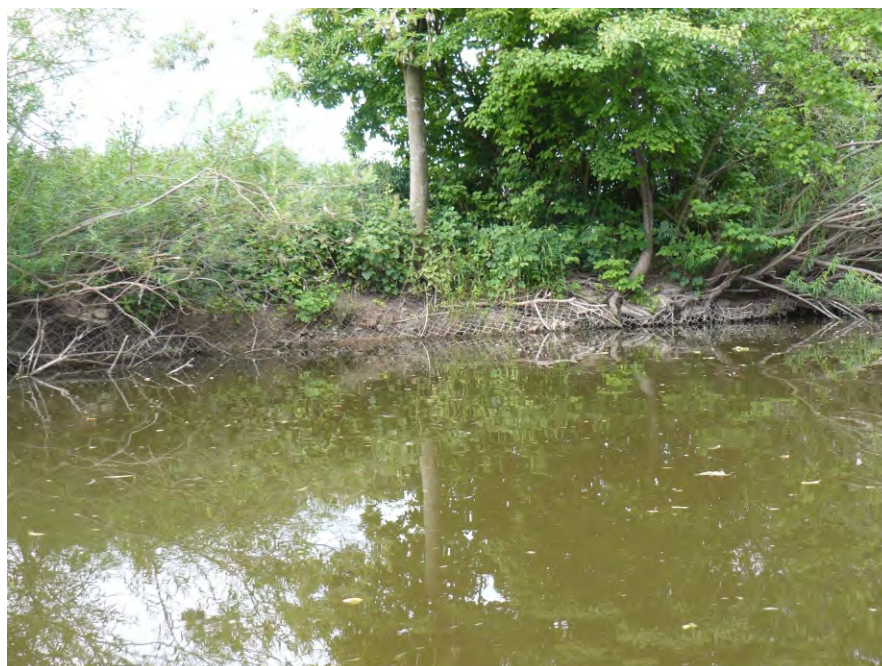
Bild 8: Uferverbau mit Drahtsteinmatten am Kocher westlich Kochersteinsfeld C. Andres, 31.05.2011
