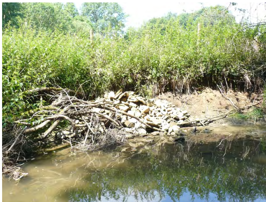
Bild 12: Neue Steinschüttung an einem Prallhang an der Kupfer südöstlich von Ulrichsberg C. Andres, 04.07.2011
