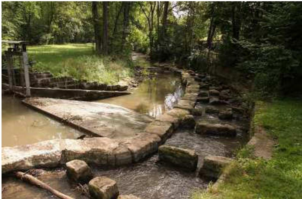
**Bild 6:** Fischaufstiegsanlage an einem Wehr an der Metter.
