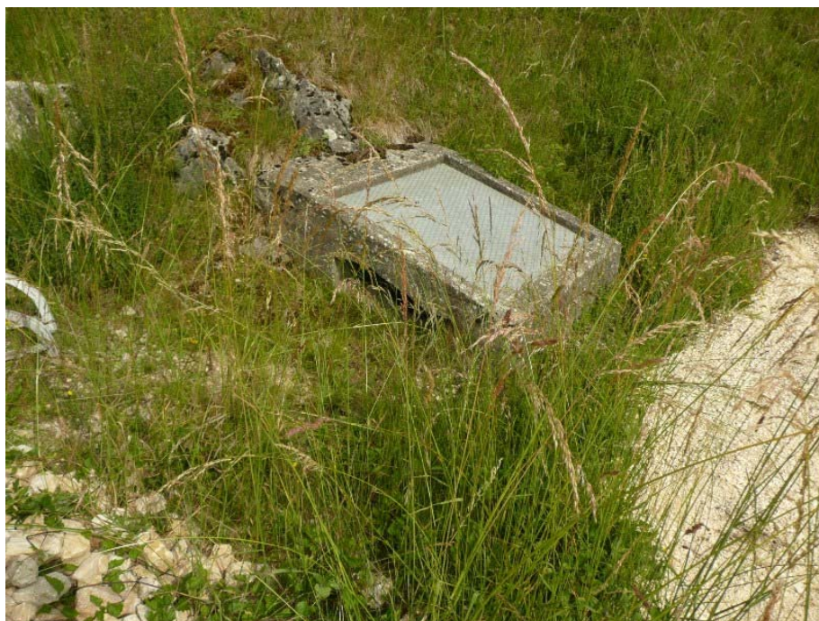
Bild 19: Alheimer Klufthöhle im Steinbruch Alheim mit Betonfassung, Verschluss und Durchlass an der Seite
