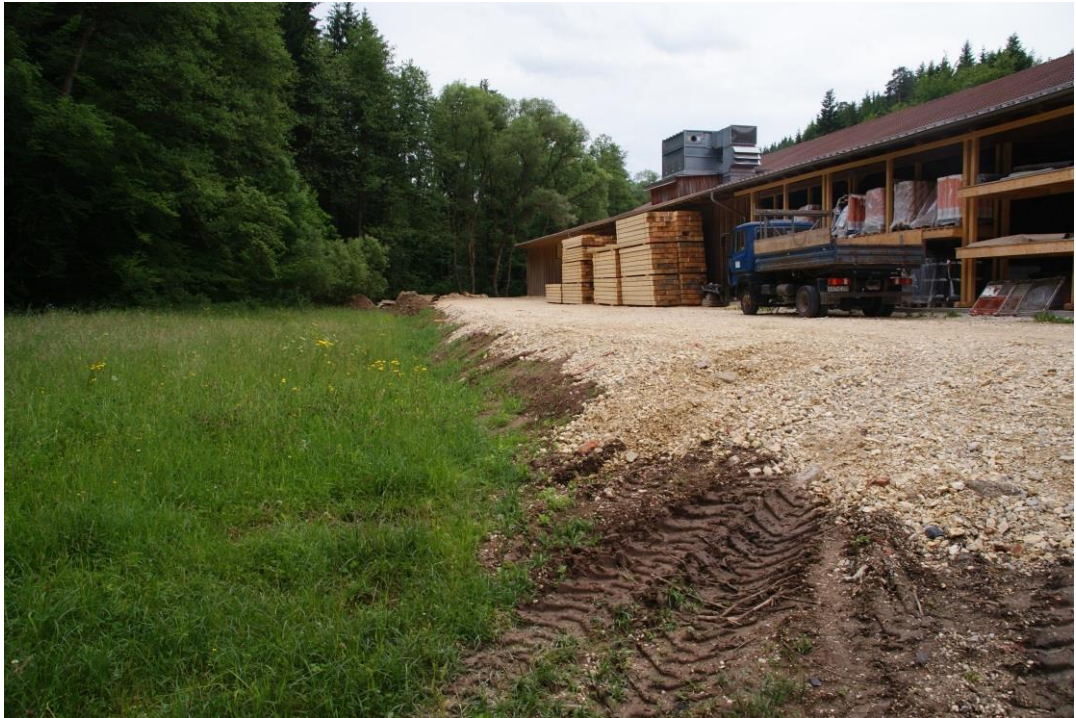
Bild 31: Öl- und Sägemühle im Tal der Blinden Rot. Das Betriebsgelände reicht teilweise in den Bereich des dortigen Naturschutzgebietes hinein. K. Böger, 07.06.2012
