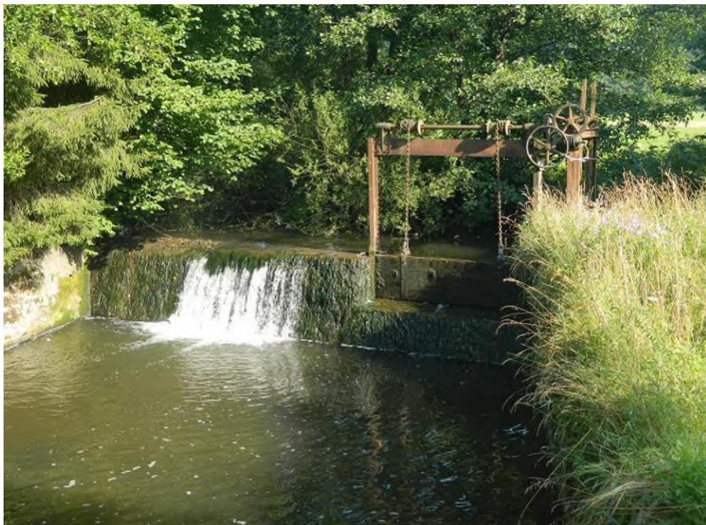
**Bild 36:** Mühlenwehr an der Fichtenberger Rot nahe Wielandsweiler, das zur Unterbrechung der Durchgängigkeit und zur Bildung einer Rückstaustricke bachaufwärts führt.
