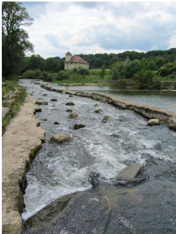
**Bild 12:** Zahlreiche bisher durchgeführte Maßnahmen dienen der Verbesserung der Durchgängigkeit (Fischtreppe an der Jagst beim Kraftwerk Duttenberg); R. Ritz, 26.06.2013
