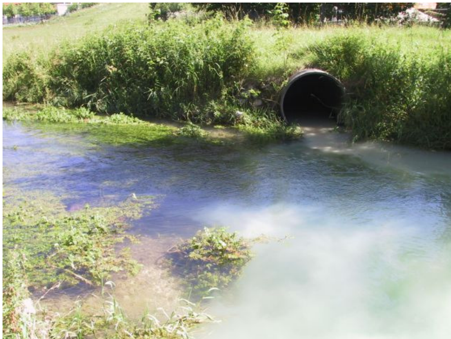
Bild 22: Auslauf des Regenüberlaufbeckens (RÜB) unterhalb Trochtelfingens. Auch wenn der hier erkennbare Stoffeintrag durch Sanierungsarbeiten bedingt ist, kann es durch das RÜB im laufenden Betrieb zu stoßweisen Belastungen des Gewässers kommen; Teilgebiet Flachsbühl/Seckach. LRT-Erfassungseinheit 1.5 H. Grüllmeier, 19.7.2006
