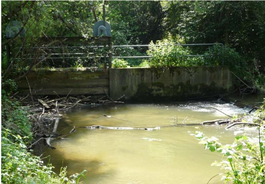
Bild 21: Stautufe (Auslaufbauwerk zur Speisung des Schwarzen Grabens) in der Salemer Aach südlich der Kläranlage von Frickingen
