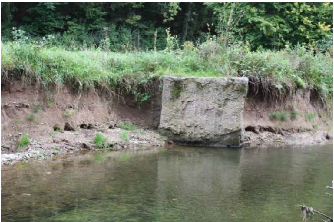
Bild 6: Uferanbruch der Starzel (Lebensraumtyp [3260]). Ein großer Betonklotz wurde eingebracht, um die Auskolkung zu unterbinden (Prof. Dr. Konrad Reidl, September 2010).
