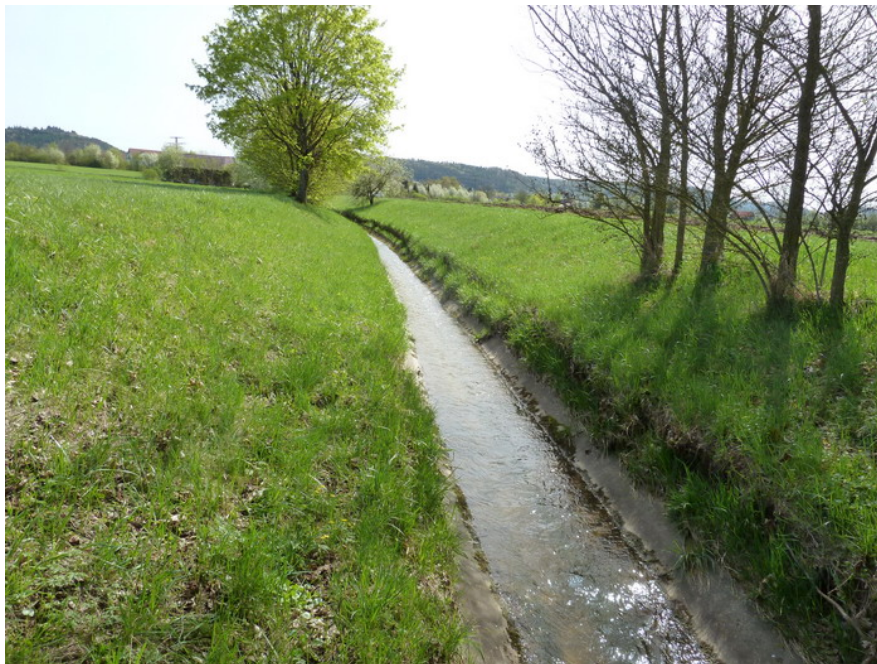
Bild 38: Der in Betonsohlschalen geführte Bühlertalbach kurz vor seiner Einmündung in den Neckar.
