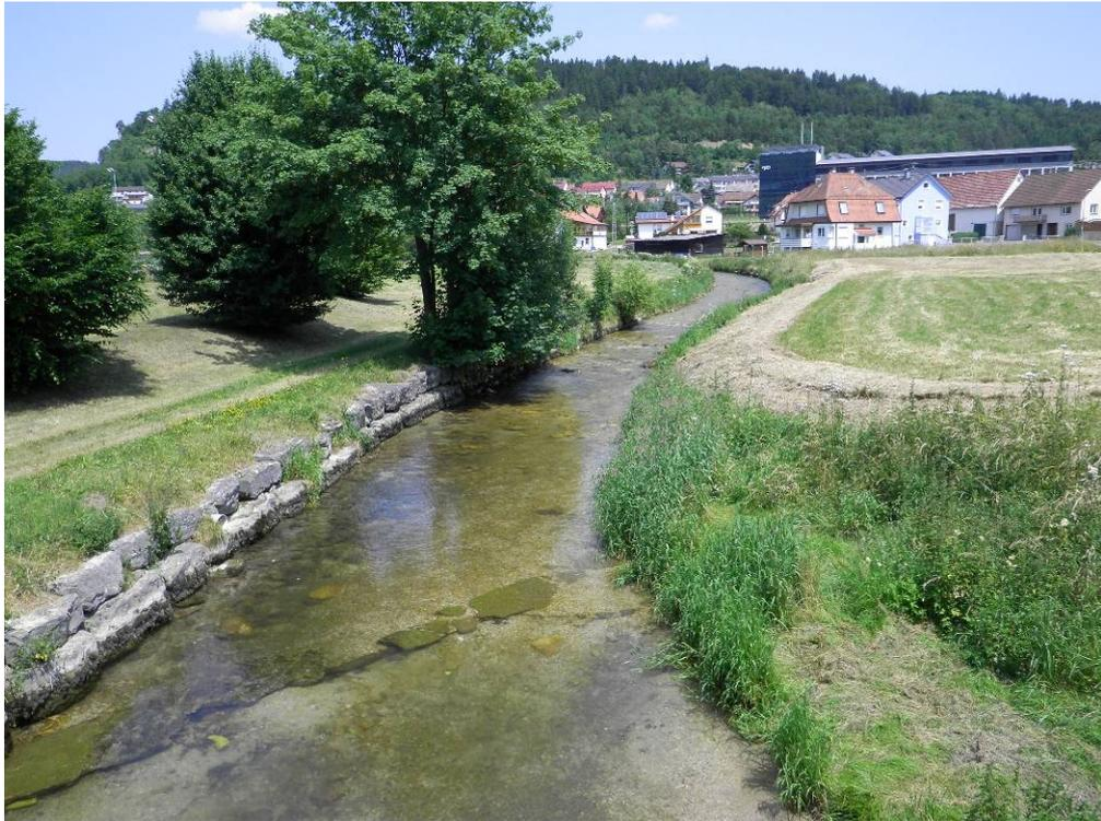
**Bild 7:** Schmeie mit Verbau aus Ufersteinen und nur sehr schmalem ungenutztem Ufersaum im Bereich Straßberg
