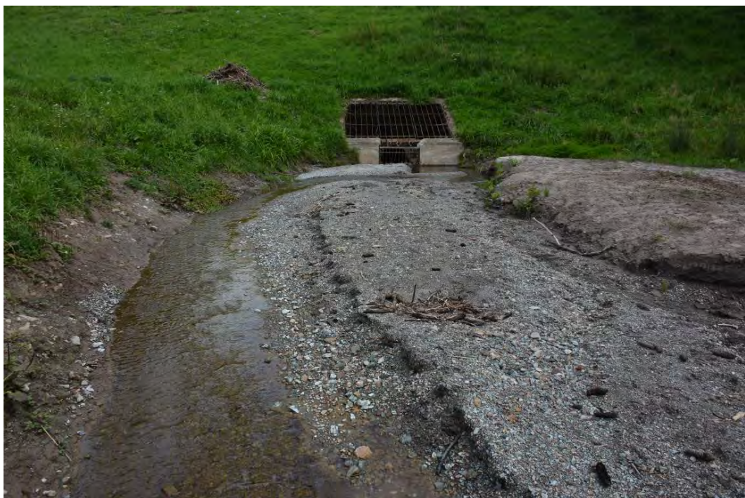
Bild 64: Einlaufbauwerk des Hochwasserrückhaltebeckens Rötenbach: Die Verrohrung am Rückhaltebecken trennt die Steinkrebspopulation. F. PÄTZOLD, 25.05.2014
