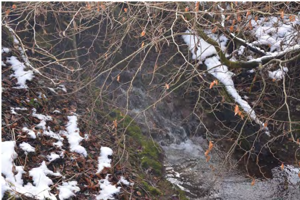
Bild 50: Keinbach: Ein Absturz an der Feldwegquerung verhindert eine Durchgängigkeit.
