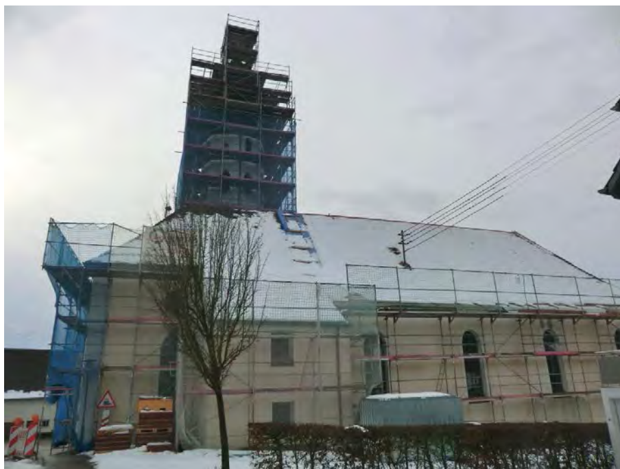
Bild 26: Lebensstätte des Großen Mausohrs ( Myotis myotis ). Wochenstubenquartier im Dachstuhl und Turm der Menninger Kirche St. Johannes. Bild zeigt Zustand während Sanierungs- und Renovierungsmaßnahmen im Winter 2014/15. Jochen Berger, 24.02.2015
