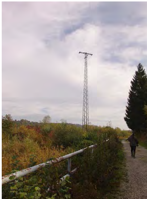
Bild 47: Beeinträchtigung durch den Vogelsee querende Freileitung.
