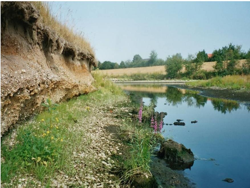
**Bild 18: Steilufer im Bereich der Mündung der Schutter in die Kinzig im Jahr 2016; dieser Flusslauf wurde 2001 auf einer Länge von 600 m neu hergestellt und ersetzte einen Betonabsturz**
