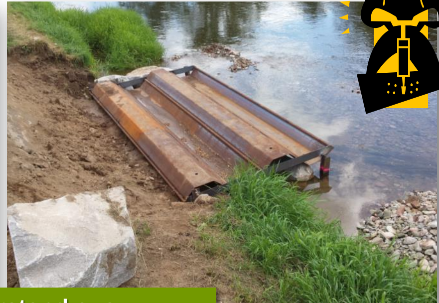
Fischunterstand aus Stahlspundwandbohlen
