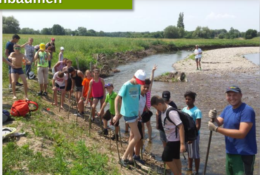
Weidenspreitlage und Fußsicherung aus Rohbäumen
