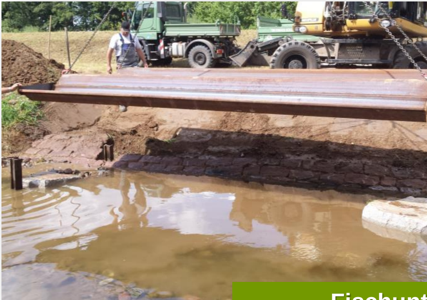
Fischunterstand aus Stahlspundwandbohlen
