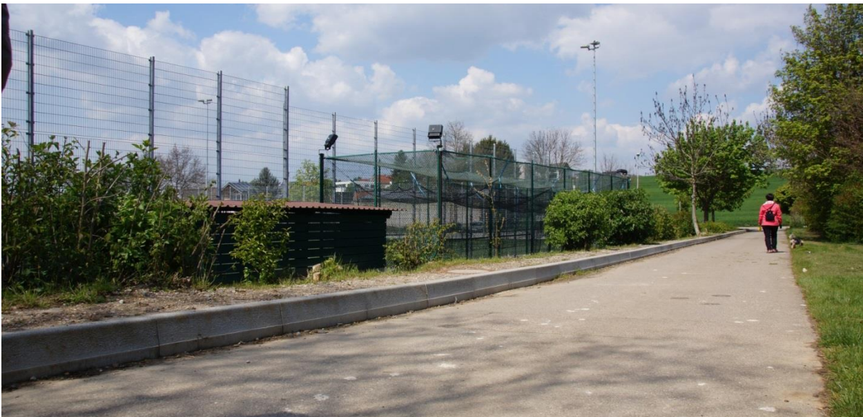
Abbildung 11: talquerender Hochbord zwischen Verdolungseinlauf (rechts) und Sportplatz (links) (Aufnahmepunkt: Pfeil Nr. 9 in Abbildung 1)
