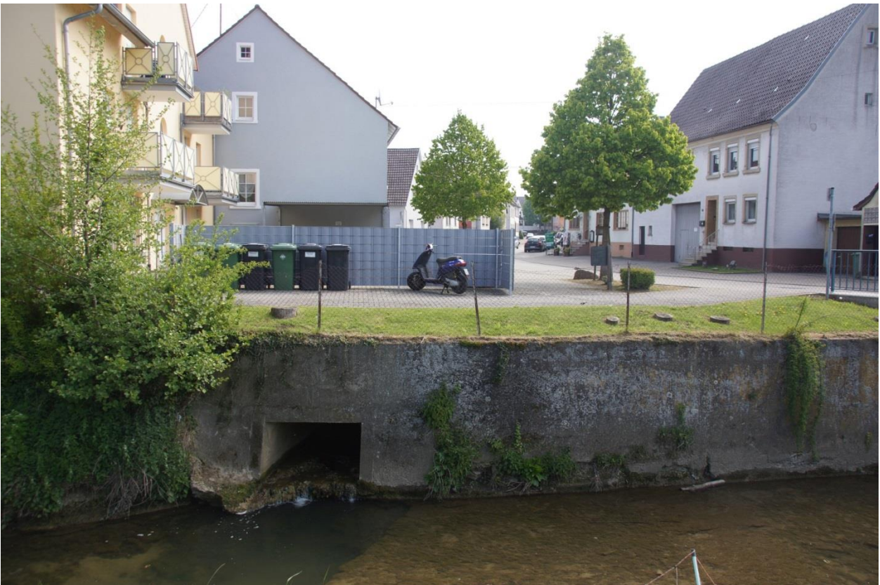
Abbildung 7: Zulauf Verdolung DN600 oberhalb des Sportplatzes (Aufnahmepunkt: Pfeil Nr. 6 in Abbildung 1)
