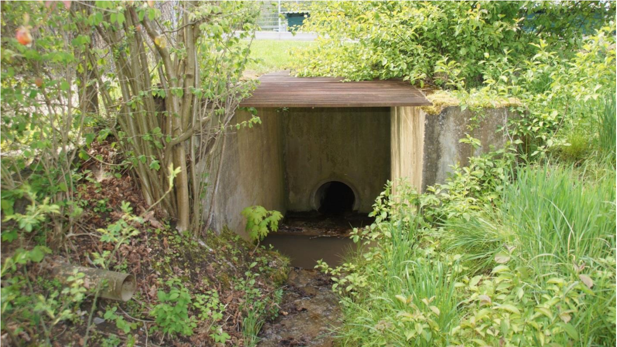
Abbildung 7: Zulauf Verdolung DN600 oberhalb des Sportplatzes (Aufnahmepunkt: Pfeil Nr. 6 in Abbildung 1)
