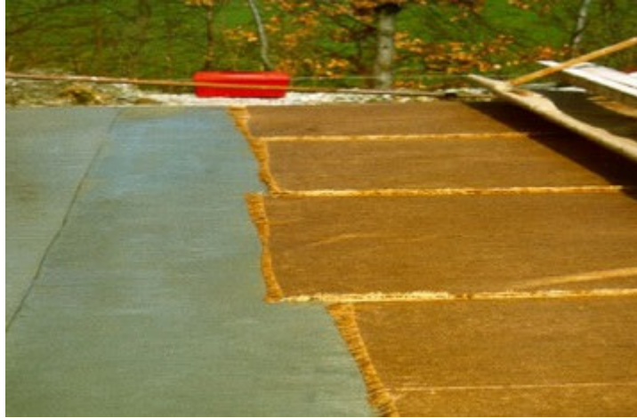
Bild 36: Oberflächenstrukturierung Jutetuchbeton [66]
