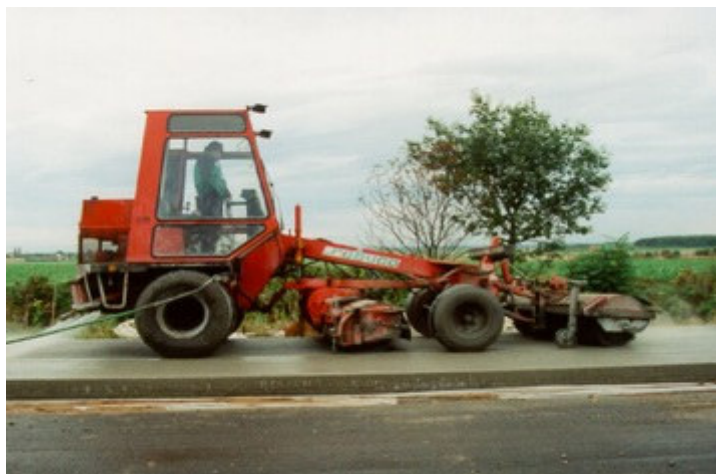
Bild 37: Oberflächenstrukturierung Waschbeton [66]
