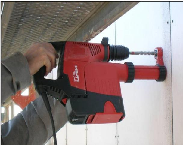
**BT 12** – Anbohrverfahren zum Anbringen von Gerüstverankerungen und zur Instandhaltung an Fassaden
