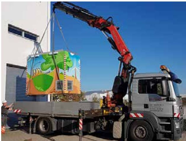
Abb. 1.1: Verladung des neuen Messcontainers
