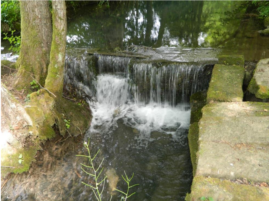
Bild 5: Nicht durchgängiger Gewässerabsturz am Fischbach bei Sennfeld C. Vogt-Rosendorff, 28.05.2015
