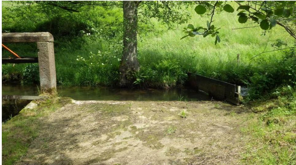
**Bild 5:** Finkenbach mit Wehr als Wanderhindernis. Nach rechts fließender Ast bildet den Mühlgraben einer Wasserkraftanlage in Ober-Hainbrunn.
